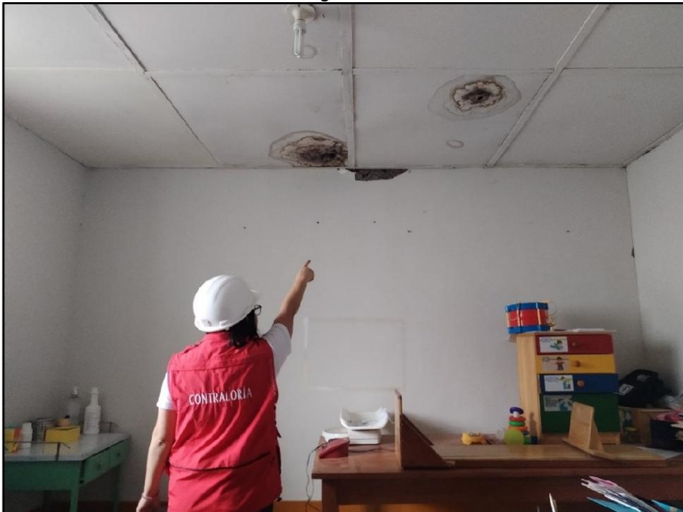
Descripción: Estado actual del cielorraso, con presencia de goteras y moho del EE.SS. de Vituya.
