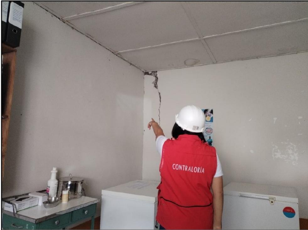
Descripción: Presencia de grietas en muros internos del EE.SS. de Vituya.
