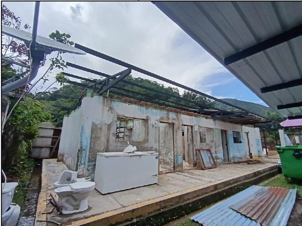
**Descripción:** Muro de adobe en mal estado debido a la falta de colocación de cobertura por parte del contratista.
