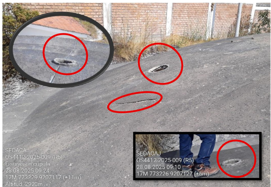
Fotografía n.º 137 Respiradero sin protección y fisura del concreto en la cúpula
