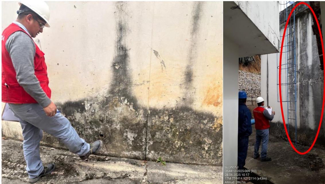
Fotografía n.º 136 Deterioro de pintura de las paredes del reservorio
