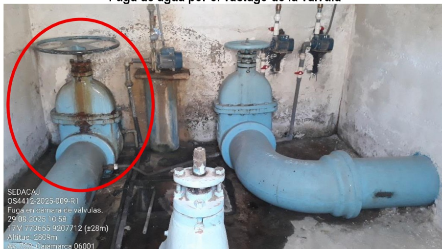
Fotografía n.º 106 Fuga de agua por el vástago de la válvula
