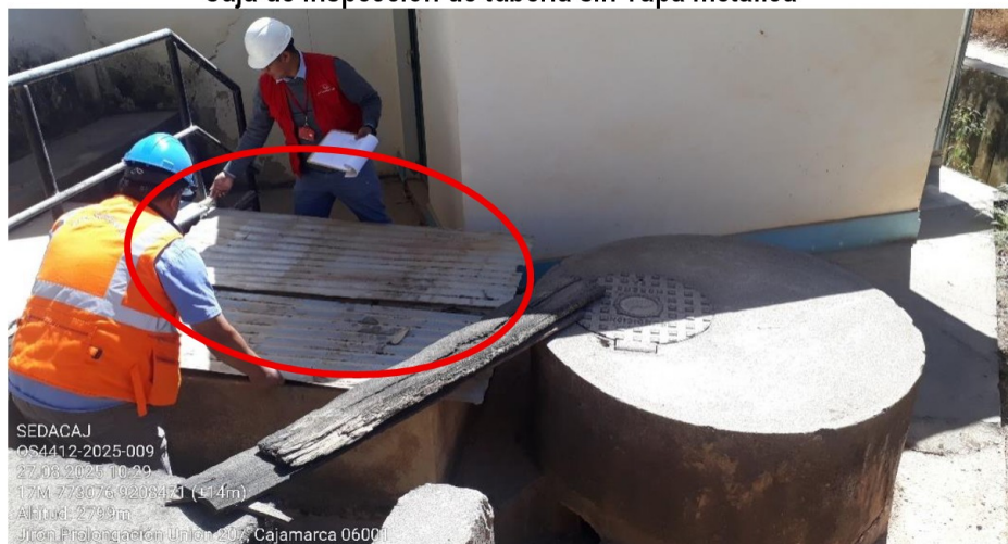
Fotografía n.º 92 Caja de inspección de tubería sin Tapa metálica
