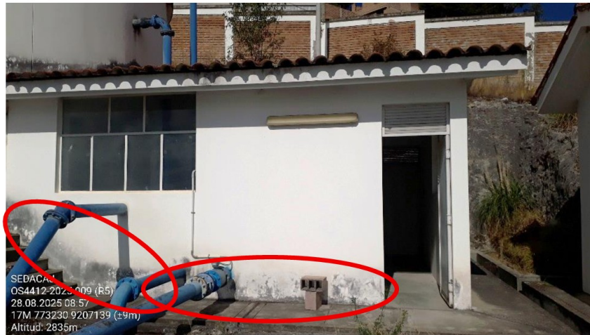
Fotografía n.º 153 Pintura deteriorada en la caseta de válvulas
