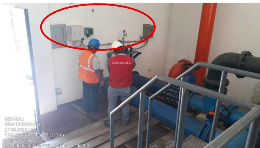
Fotografía n.º 99 No existe señalización de prevención o peligro
