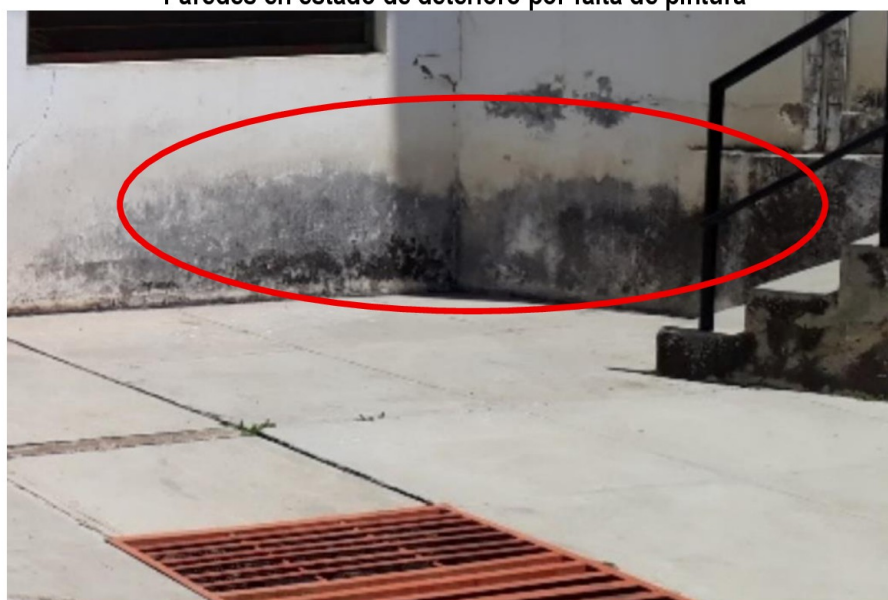
Fotografía n.º 102 Paredes en estado de deterioro por falta de pintura
