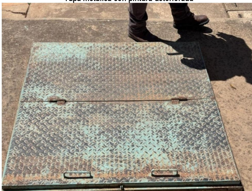
Fotografía n.º 90 Tapa metálica con pintura deteriorada
