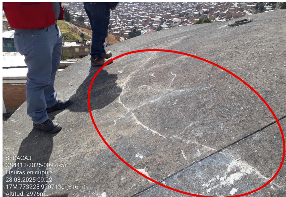
Fotografía n.º 136 Fisuras graves en la cúpula de concreto del reservorio
