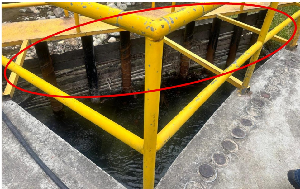
Fotografía n.º 23 Instalación de maderas y palos en forma de rejilla
