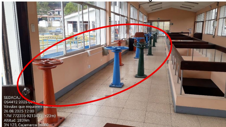
Fotografía n.º 58 Válvulas de los filtros antiguos
