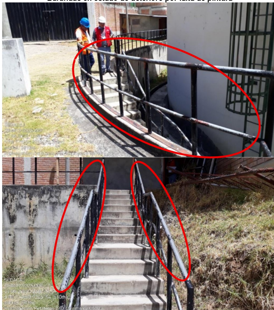
Fotografía n.º 101 Barandas en estado de deterioro por falta de pintura
