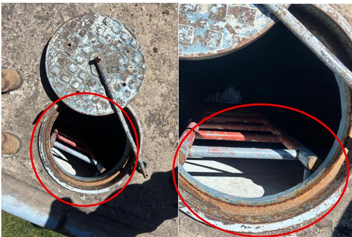
Fotografía n.º 118 Tapa metálica y escalera interior con signos de oxidación
