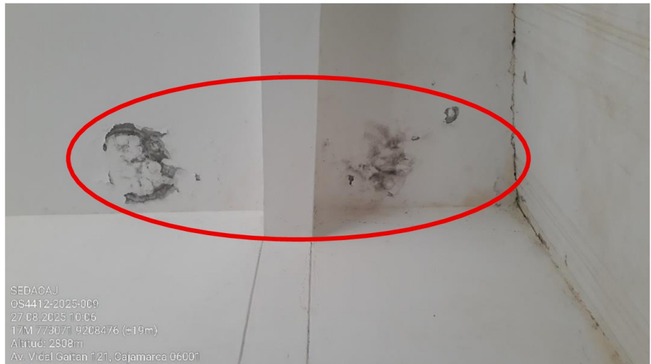
Fotografía n.º 85 Deterioro de pintura de las paredes del reservorio
