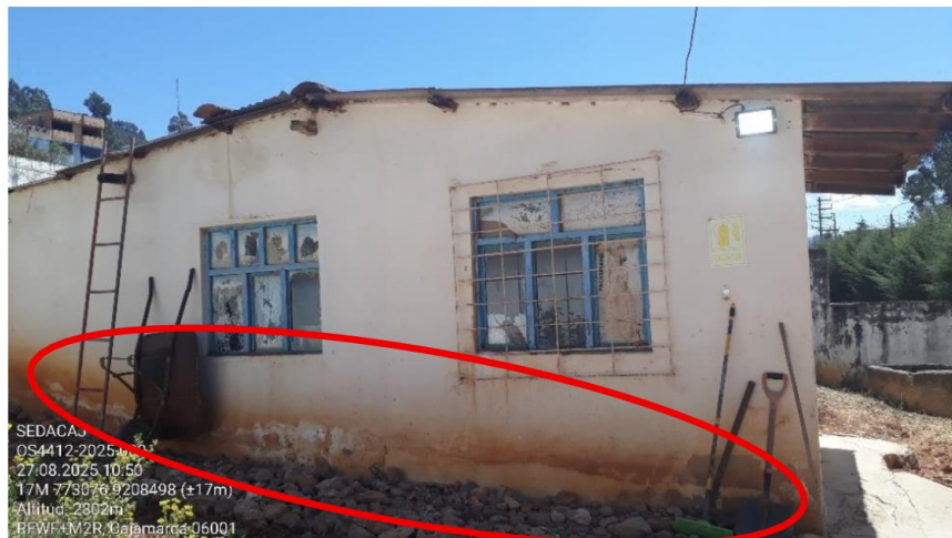
Fotografía n.º 86 Deterioro de pintura de las paredes de la caseta de guardianía
