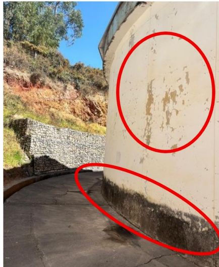
Fotografía n.º 86 Deterioro de pintura de las paredes de la caseta de guardianía
