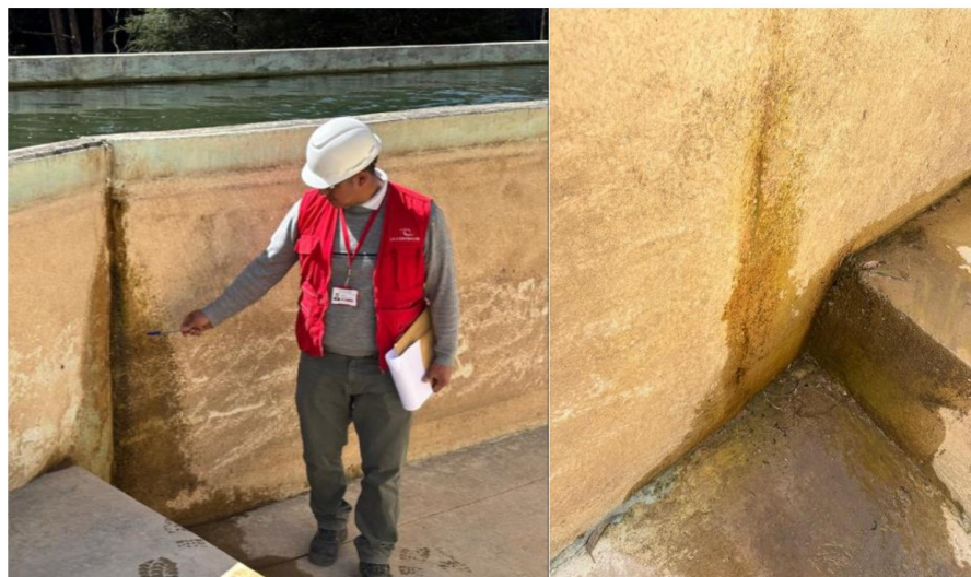
Fotografía n.º 54 Filtración en los muros interiores del desarenador
