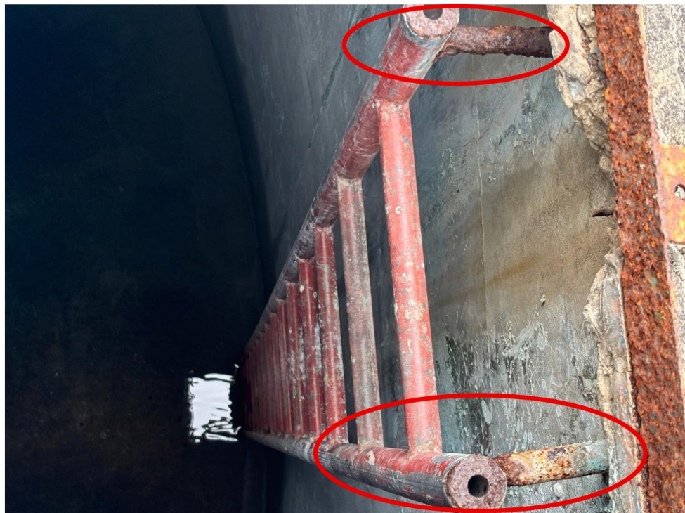
Fotografía n.º 129 Escalera de ingreso al reservorio con signos de corrosión
