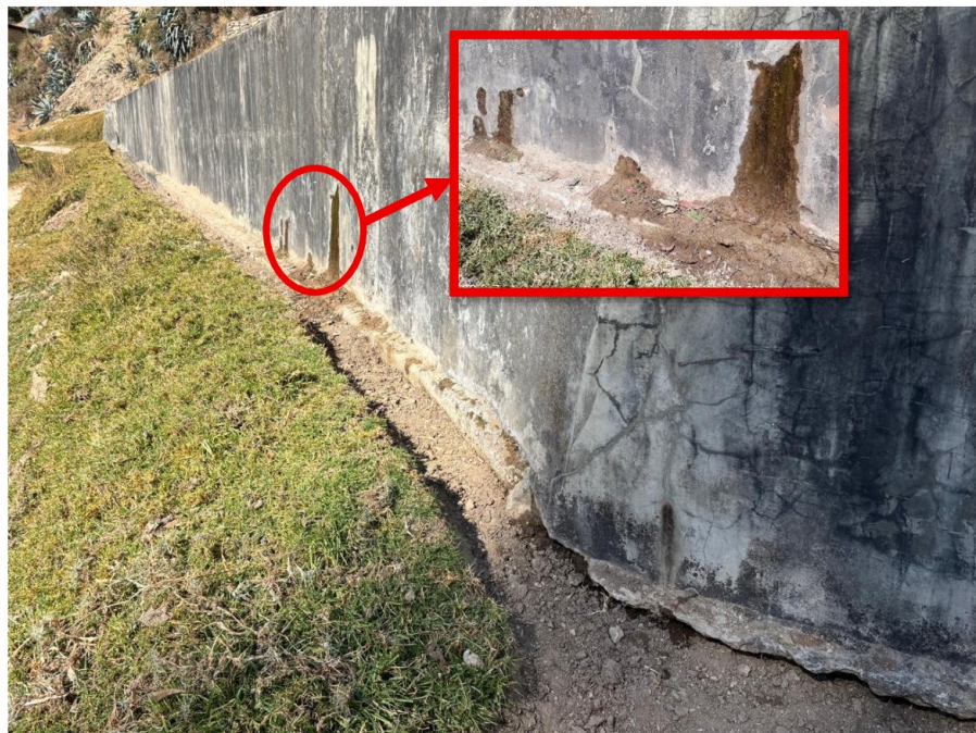
Fotografía n.º 52 Filtración en los muros exteriores del desarenador
