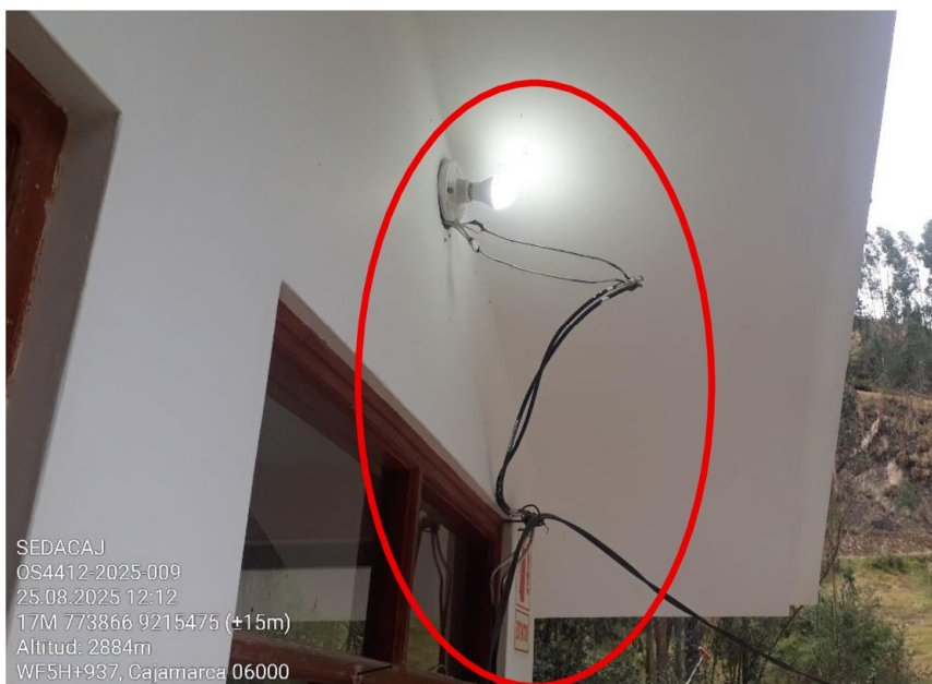
Fotografía n.º 14 Cables de alimentación de energía eléctrica a la luminaria expuesta a la intemperie.
