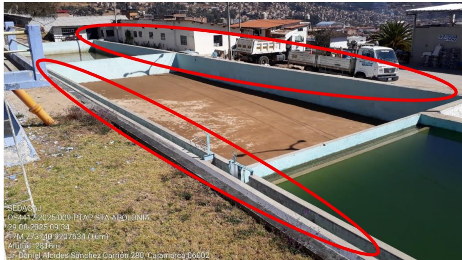
Fotografía n.º 65 Filtro sin barandas de protección
