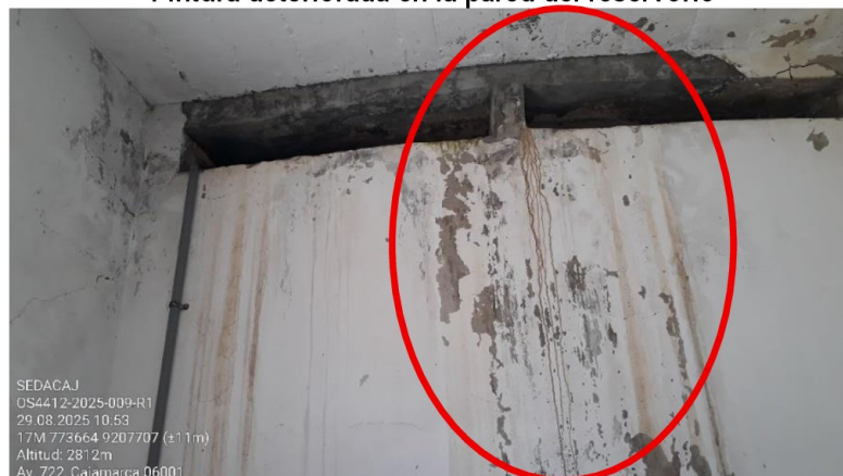
Fotografía n.º 112 Pintura deteriorada en la pared del reservorio
