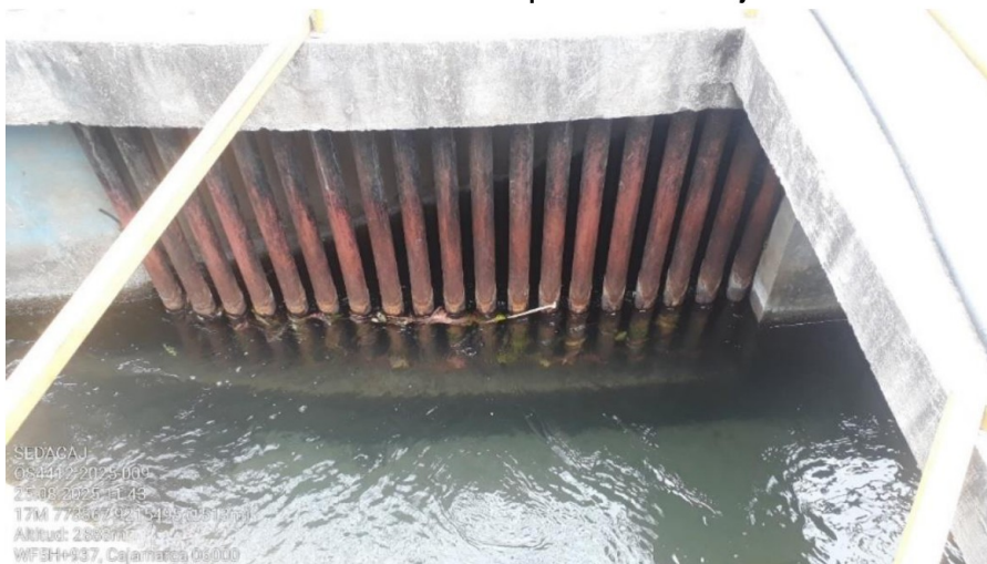
Fotografía n.º 21 Falta pintado de las rejillas
