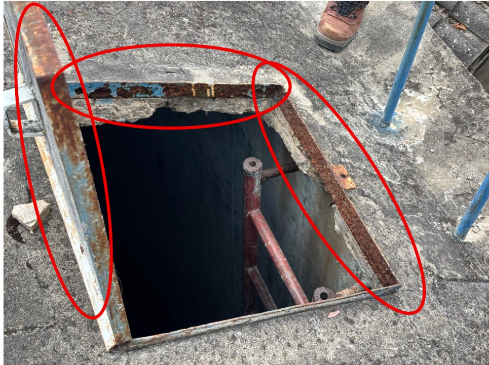
Fotografía n.º 128 Tapa de ingreso al reservorio con presencia de óxido
