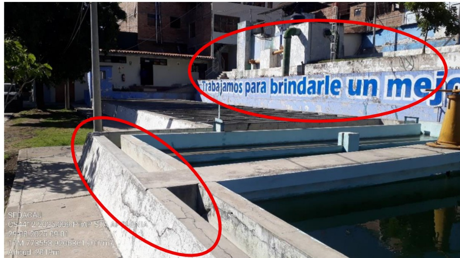
Fotografía n.º 70 Falta de mantenimiento de pintura y se evidencia fisuras
