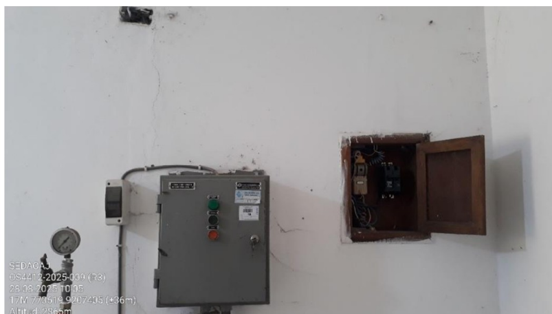
Fotografía n.º 125 Falta de señalización en los tableros
