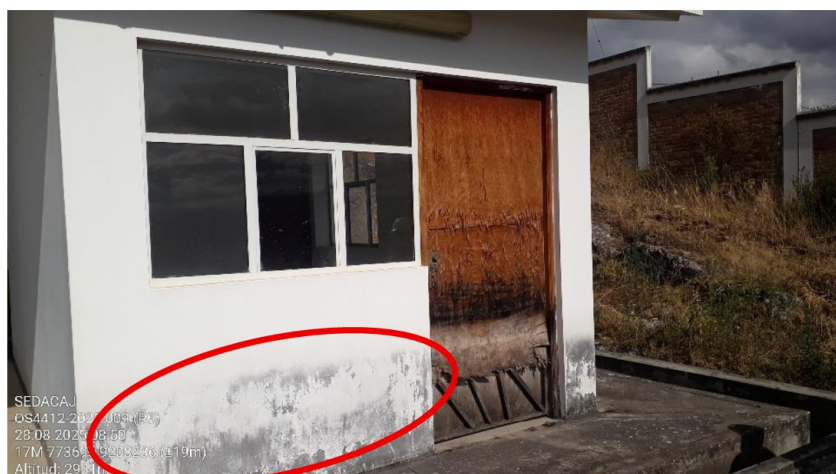
Fotografía n.º 147 Pintura deteriorada en la caseta de vigilancia
