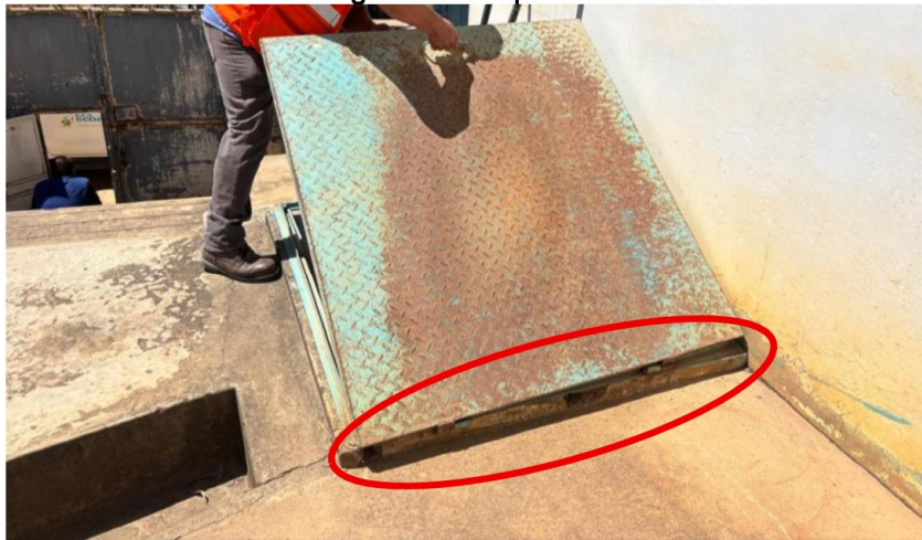
Fotografía n.º 91 Bisagras de la Tapa metálica rota
