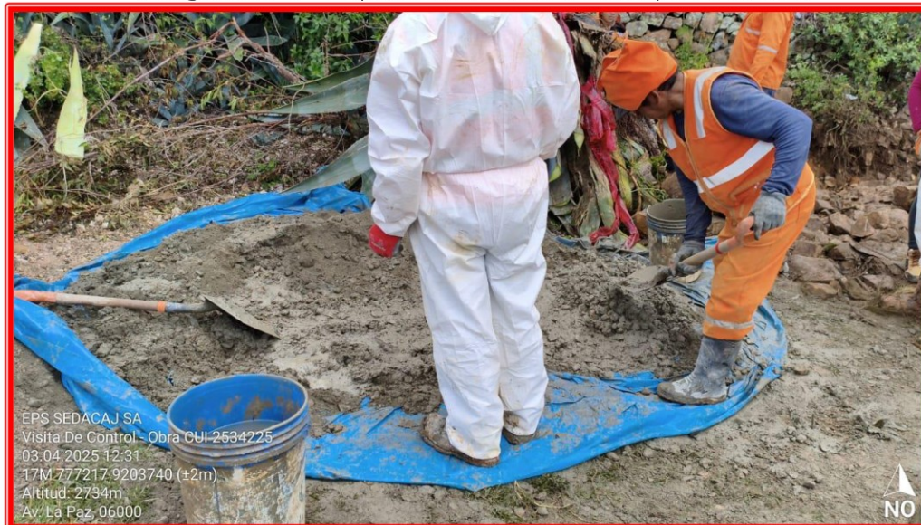
Fotografía n.° 4: Preparación manual de la mezcla por los obreros.
