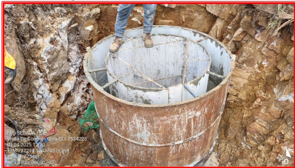
Fotografía n.° 3: Buzón encofrado y vaciado hasta la mitad.
