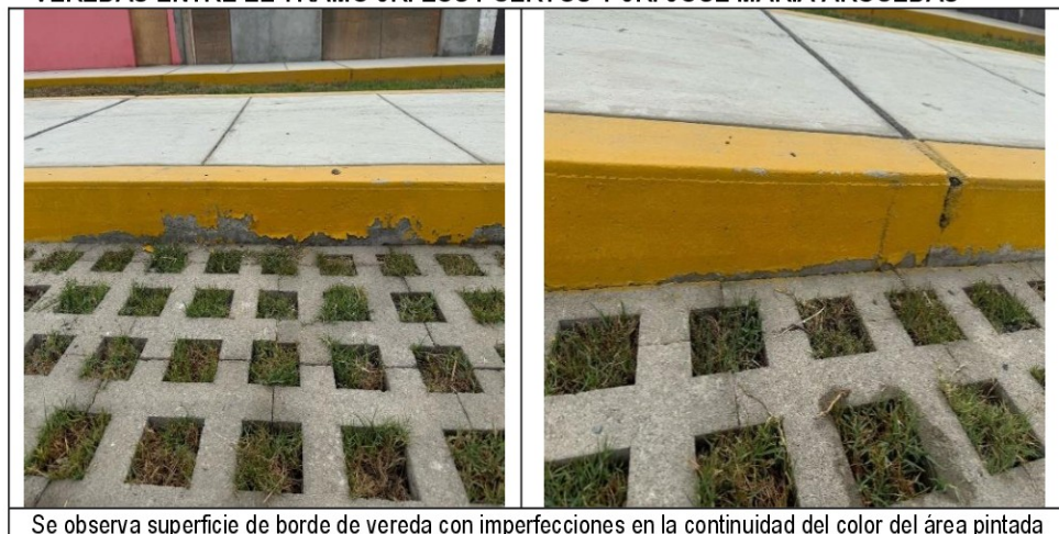
IMAGEN N°s 22 Y 23 VEREDAS ENTRE EL TRAMO JR. LOS PUERTOS Y JR. JOSÉ MARÍA ARGUEDAS
