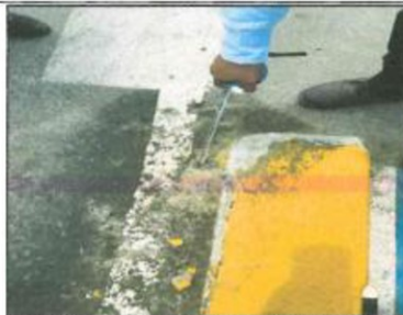
FOTOGRAFÍA N° 65 DESGASTE DE LA CARPETA ASFALTICA
