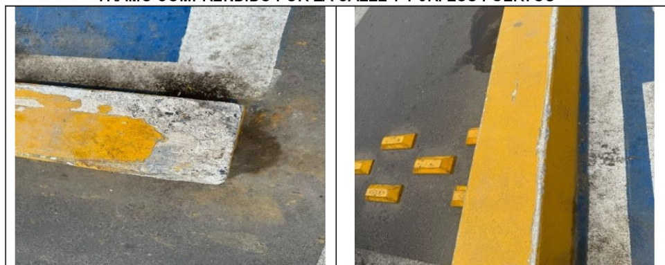
IMAGEN N°s 18 Y 19 TRAMO COMPRENDIDO POR LA CALLE 1 Y JR. LOS PUERTOS
