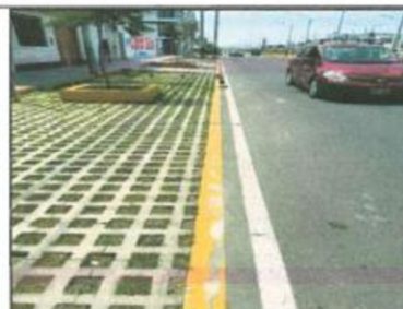
FOTOGRAFÍA N° 50 RESQUEBRAJAMIENTO DE LA PINTURA DE TRÁFICO EN EL BORDE DEL SARDINEL
