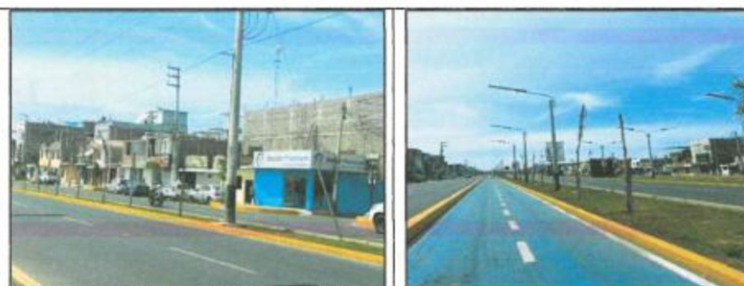
FOTOGRAFÍA N° 47 Y 48 SUMINISTRO DE PALMERAS CON TRONCOS DELGADOS, SIN PRESENCIA DE HOJAS Y CON HOJAS RESECAS
