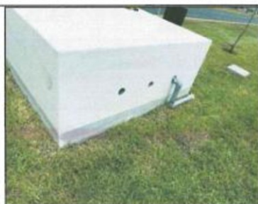
FOTOGRAFÍA N° 41 TUBERÍA DE DESFOGUE DE LA PILETA
