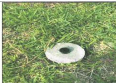
FOTOGRAFÍA N° 83 DADO DE CONCRETO SIN BOQUILLA DEL ASPELOR DIFUSOR
