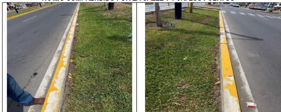
IMAGEN N°s 20 Y 21 TRAMO COMPRENDIDO POR LA CALLE 1 Y JR. LOS PUERTOS
