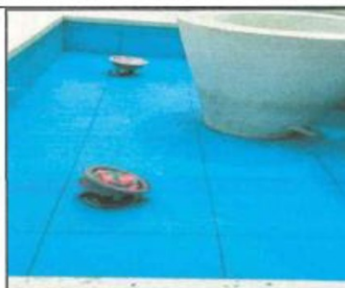
FOTOGRAFÍA N° 42 PUESTA EN FUNCIONAMIENTO DE LA LUCES
