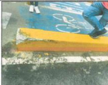
FOTOGRAFÍA N° 66 SARDINEL AGRIETADO EN LAS ESQUINAS
