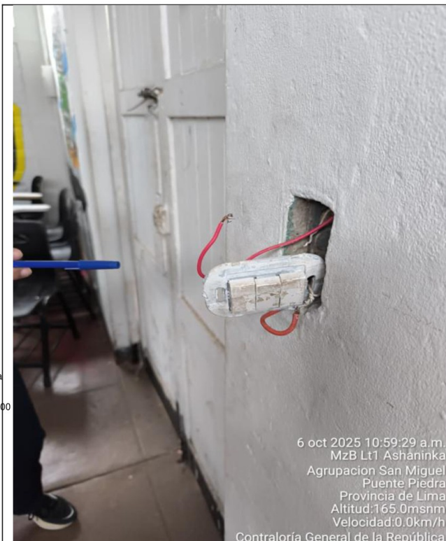
Instalaciones eléctricas deficientes (interruptor en malas condiciones) en Dormitorio
