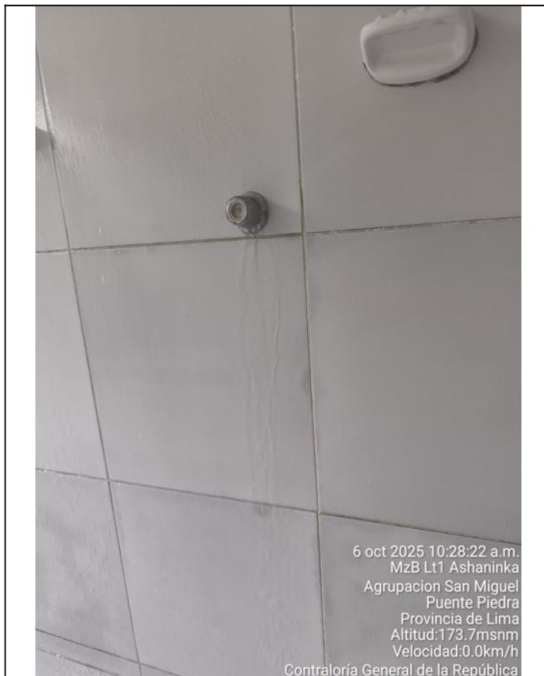
Llave de ducha malograda, presenta fuga de agua.
