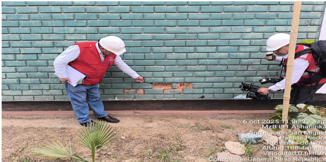
Muro de ladrillo de dormitorio afectado (desmoronándose)
