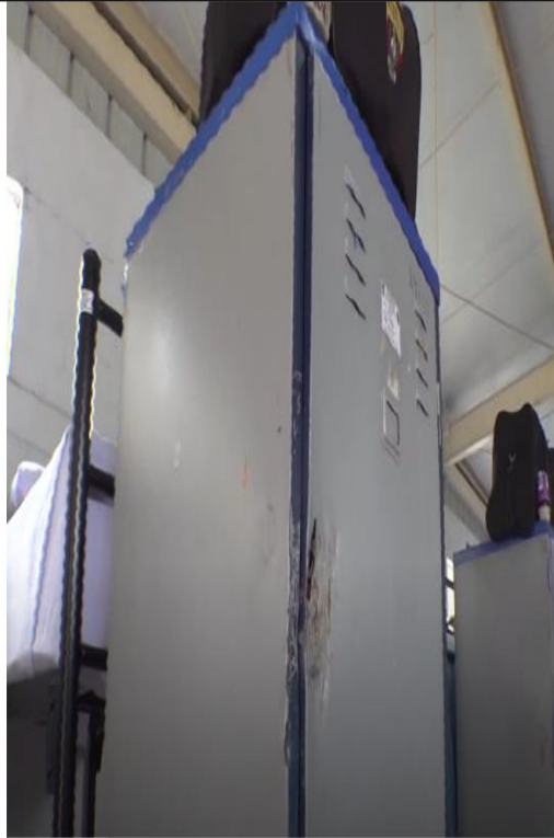
Armarios deteriorados (hundidos y sin base)
