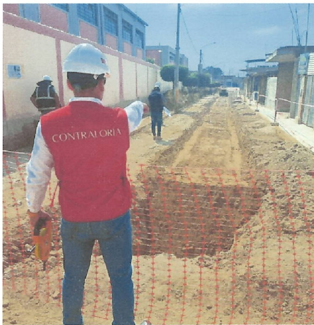
Fotografía n.º 5.- Se observa personal realizando trabajos de relleno de zanja y perfilado con un minicargador, no se evidencia trabajos de compactación.
