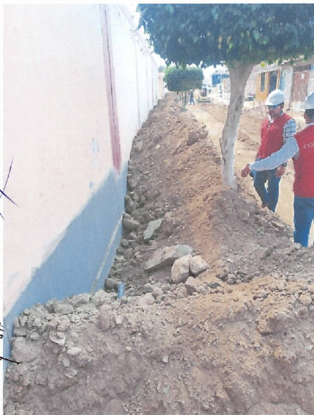
Fotografía n.º 5.- Se observa personal realizando trabajos de relleno de zanja y perfilado con un minicargador, no se evidencia trabajos de compactación.
