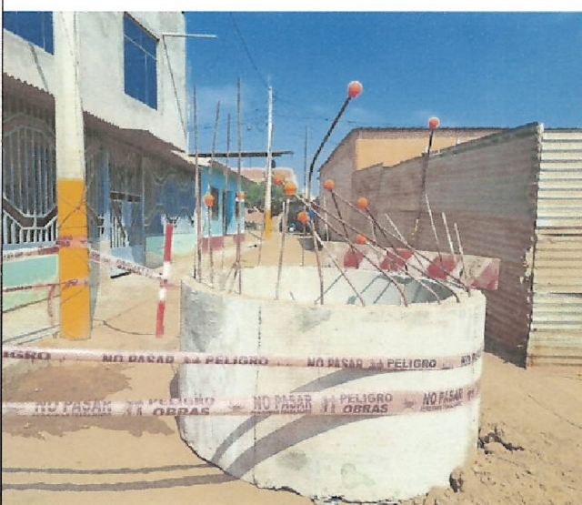
Fotografía n.º 3.- Se observa cuerpo de buzón señalizado y aislado a un costado de la vía 22 de noviembre
