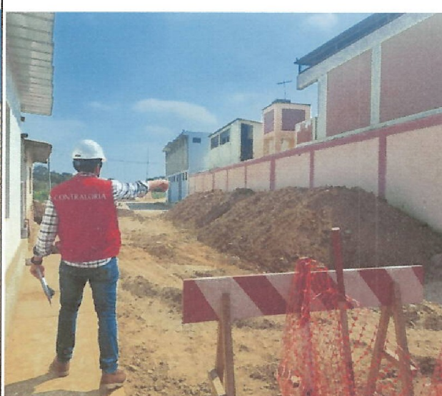
Fotografía n.º 4.- Se visualiza zona donde acumulan material de desmonte obtenido de las excavaciones en la calle 22 de noviembre
