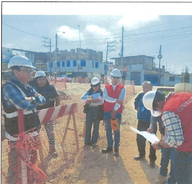
Fotografía n.º 1.- Inicio de recorrido en la calle 22 de noviembre. Revisión de planos y las zonas de intervención de la IOARR
