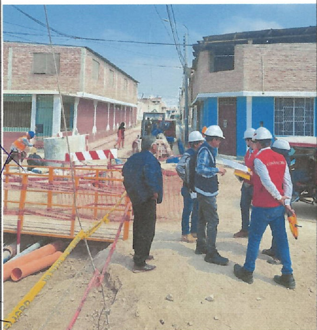
Fotografía n.º 11.- Se visualiza trabajos en la calle libertad, se observa en el fondo bomba de EPSEL trabajando realizando evacuación de aguas residuales por By-Pass
