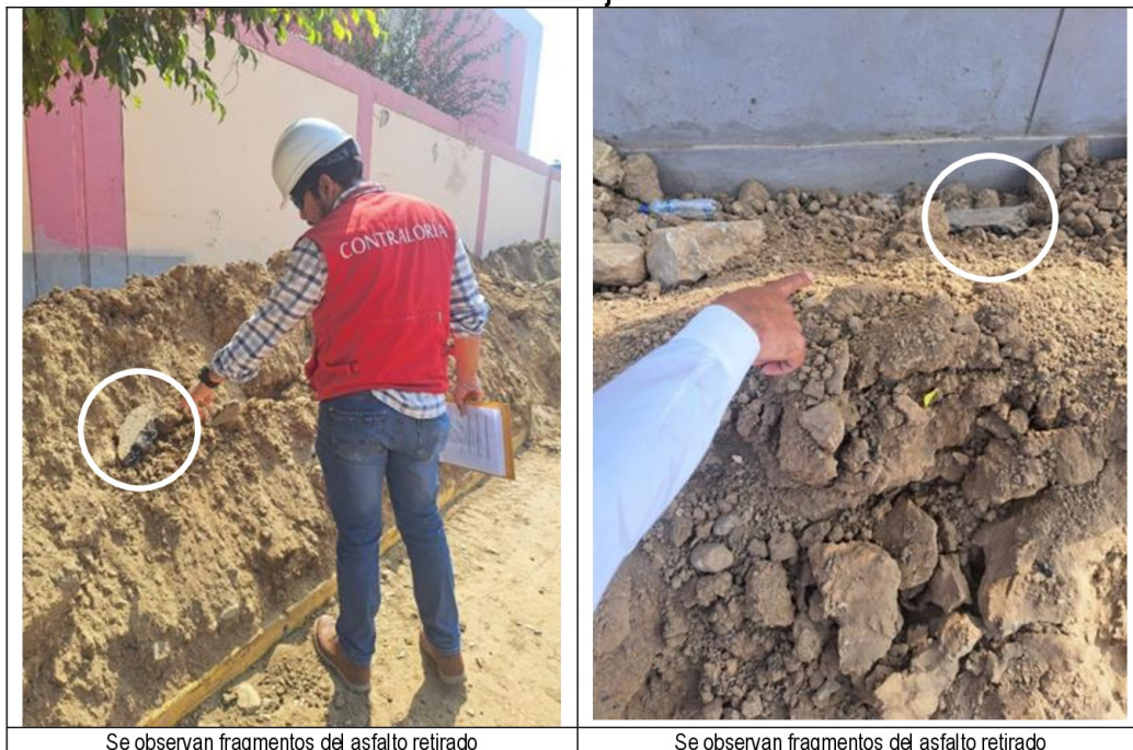
Se observan fragmentos del asfalto retirado
