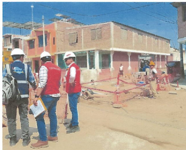
Fotografía n.º 14.- Se visualiza bomba de EPSEL en funcionamiento para bombeo por by-pass de aguas residuales
