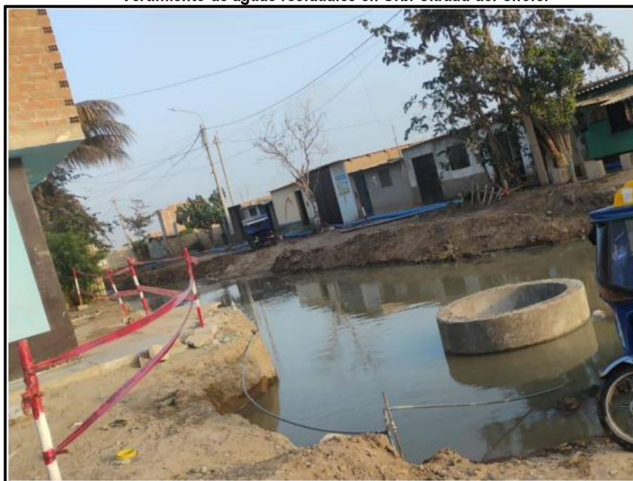
Vertimiento de aguas residuales en Urb. Ciudad del Chofer
