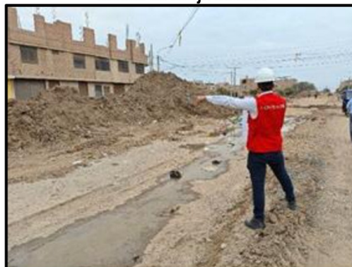
Imagen n.º 42 Tramo de zanja relleno
