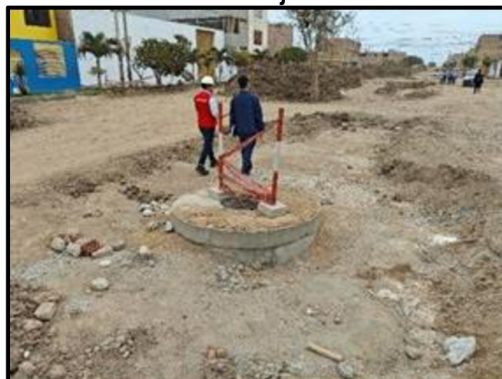
Imagen n.º 41 Tramo de zanja relleno
