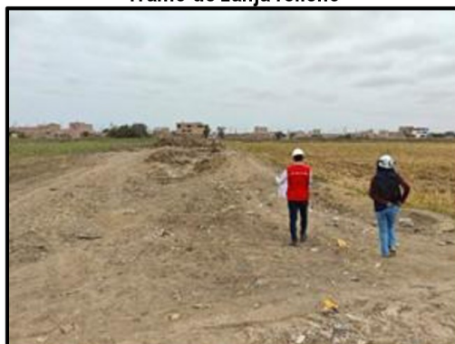
Imagen n.º 43 Tramo de zanja relleno
