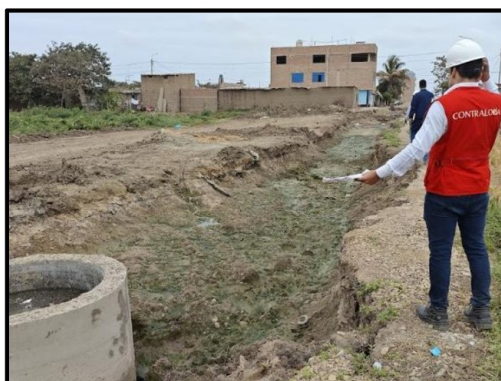
Imagen n.º 16 Represamiento del buzón n.º 136
