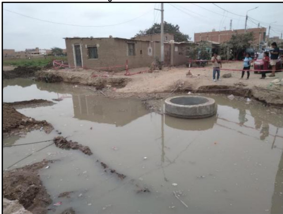
Imagen n.º 3 Vertimiento de aguas residuales en Urb. Ciudad del Chofer
