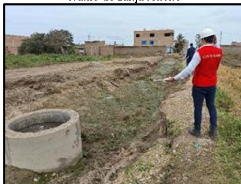
Imagen n.º 44 Tramo de zanja relleno
