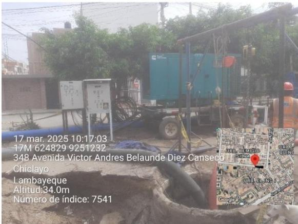
**Foto N° 02:** Tableros eléctricos y generador de energía eléctrica, a cargo de EPSEL S.A (Oficina de Mantenimiento Electromecánico) operando en la Av. Víctor Andrés Belaunde.
