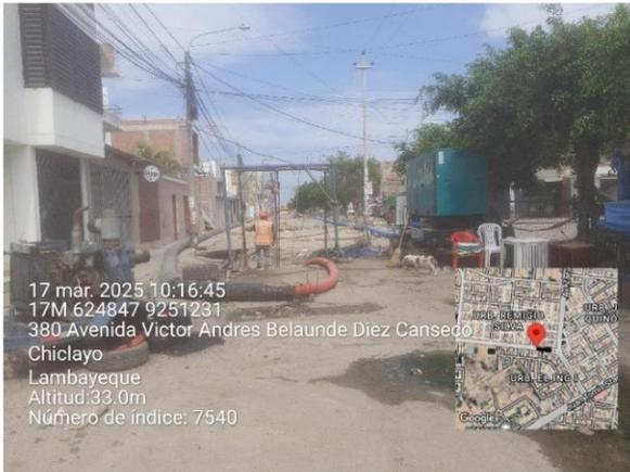
**Foto N° 01:** Personal operativo de la Oficina de Recolección, operando los equipos de bombeo (electrobombas de 10") en el proceso de trasvase de aguas servidas en la Av. Víctor Andrés Belaunde.
