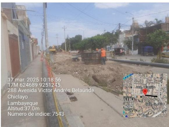
**Foto N° 03:** Personal del Contratista realizando actividades propias de la ejecución de la obra de reparación de colector primario – Emisor Norte Centro.
