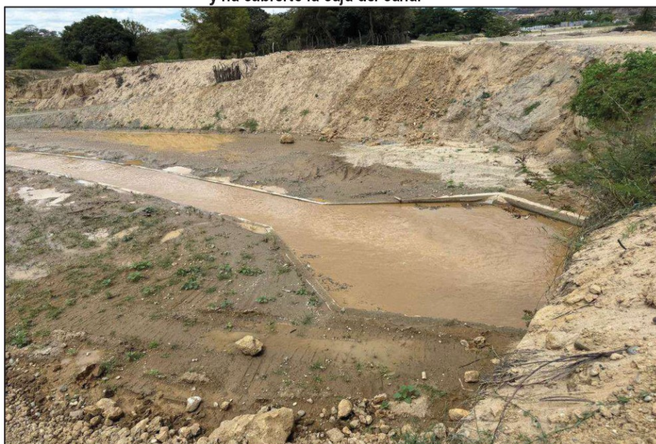
Imagen n.º 8 Sector donde el nivel de agua se ha producido desbordamiento y ha cubierto la caja del canal
