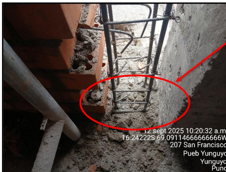
Imagen n° 2 Acero de columnas de confinamiento
