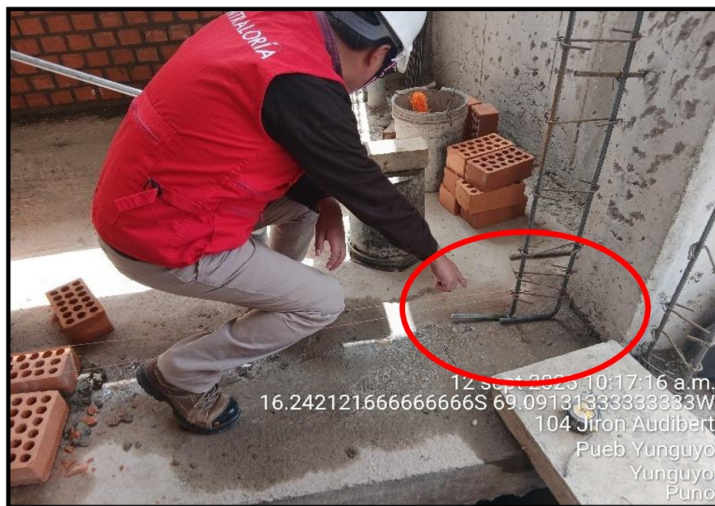
Imagen n° 3 Anclaje de las columnas de confinamiento
