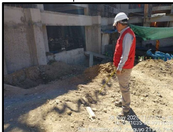
Imagen n° 1 Material de préstamo colocado en obra
