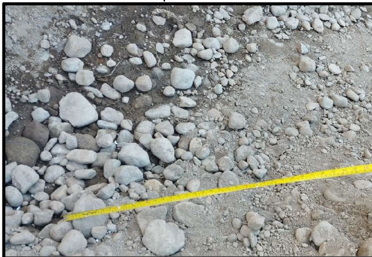
Imagen n° 2 Material de préstamo colocado en obra
