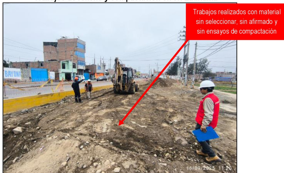
Imágenes n.º 10 y 11 Trabajos de relleno y compactación en Jr. Lauriama
