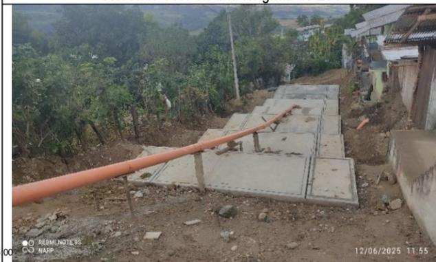
Jr. Universal L= 61 m, se verifico que se ha ejecutado trabajos de graderías en una longitud de 40 m, pendiente, veredas y sardineles y pavimento 20 m
