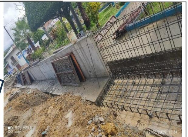
Jr. San Pedro-Muro de Contención n.º 1 de L= 55.71 m, ejecución de Concreto  $f_c = 210\text{kg/cm}^2$  en una longitud de 28 m, y amadura de acero de 4 m.
