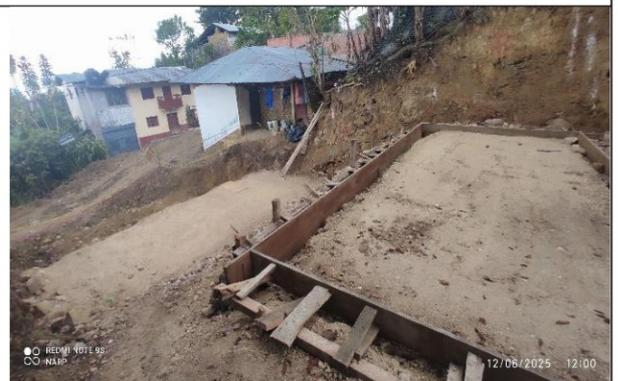
Jr. Universal L= 61 m, se verifico que colocado y compactado material granular en una longitud de 20 m, se observo que no tiene buena compactación el material
