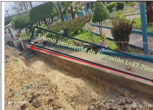
Jr. San Pedro-Muro de Contención n.º 1 de L= 55.71 m, ejecución de Concreto  $f_c = 210\text{kg/cm}^2$  en una longitud de 28 m, siendo la diferencia de 27.70 pendiente de ejecución
