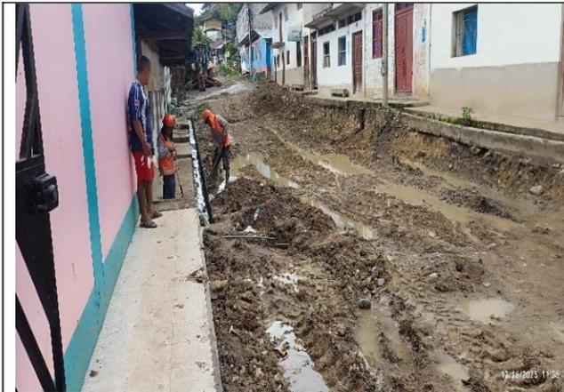
Jr. San Pedro L= 376 m, se verifico que se ha realizado corte a nivel se subrasante desde la progresiva 0+000 hasta 0+090, esta pebedinete la demolición de veredas y cunetas
