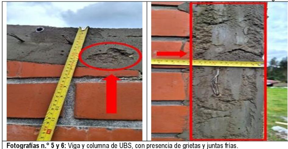
Fotografías n.º 5 y 6: Viga y columna de UBS, con presencia de grietas y juntas frías.
