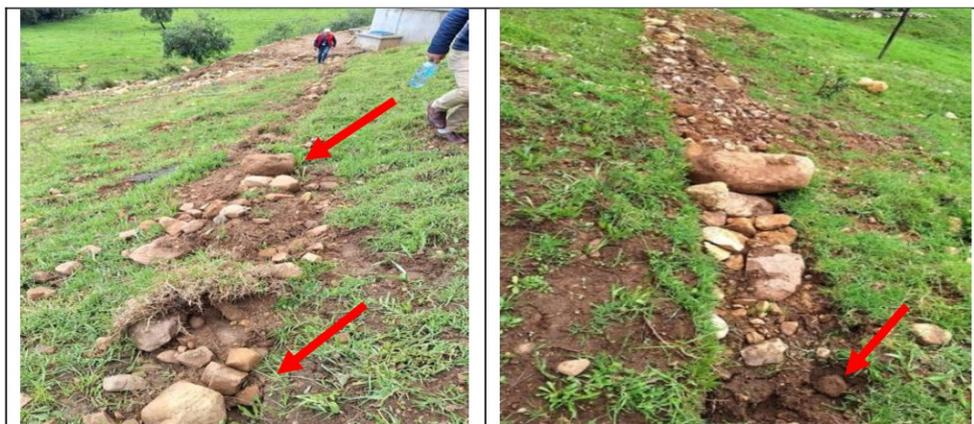
Fotografías n.º 1 y 2: Relleno de la zanja con rocas y tierra suelta, sin compactación.
