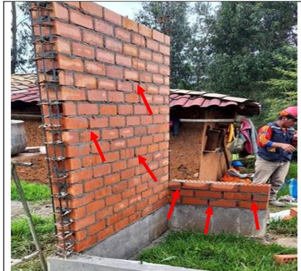
**Fotografía n.º 4:** Juntas en la cara interior del muro con deficiencias en el relleno con mortero.
