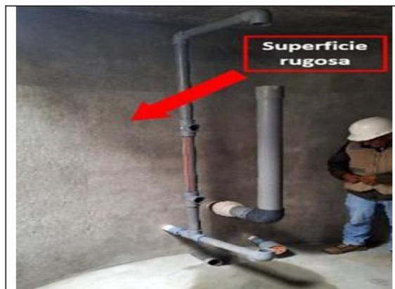
**Fotografía n.º 3:** Acabado del interior del reservorio presenta una superficie rugosa.
