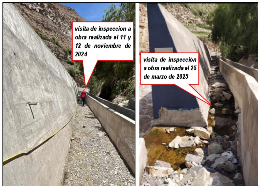
Fuente: Visita de inspección a obra realizada el 11 y 12 de noviembre de 2024, y Visita del 25 de marzo de 2025.
