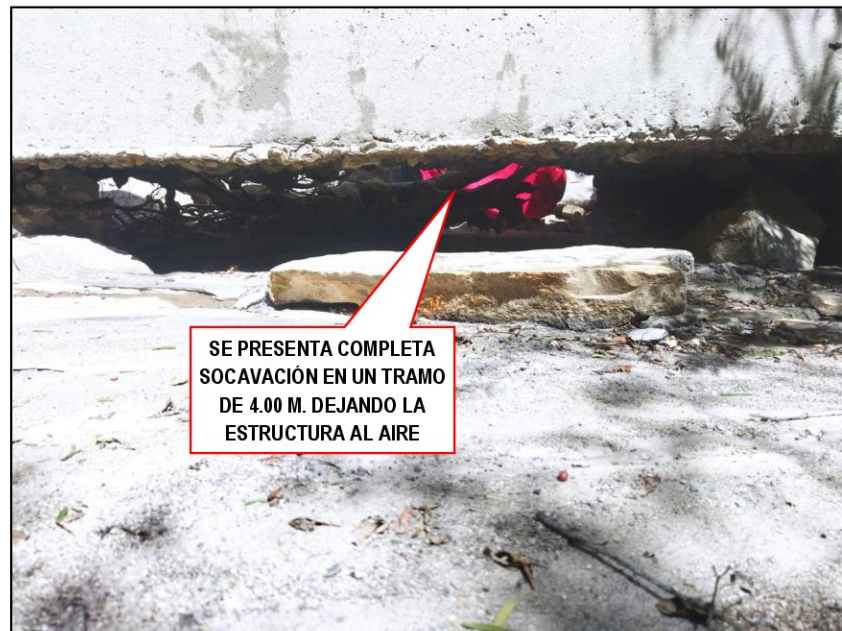
Fuente: Acta de Visita de Verificación el 25 de marzo de 2025.
