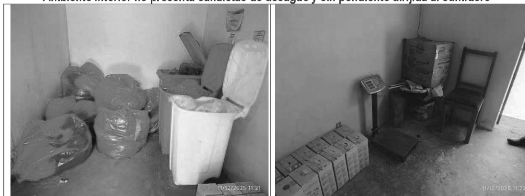
Imágenes n.ºs 4 y 5 Ambiente interior no presenta canaletas de desagüe y sin pendiente dirigida al sumidero
