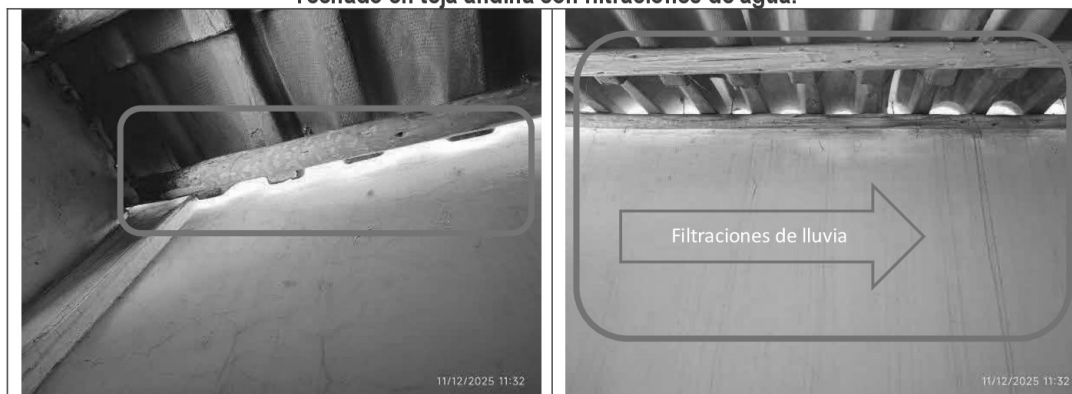
Imágenes n.ºs 2 y 3 Techado en teja andina con filtraciones de agua.
