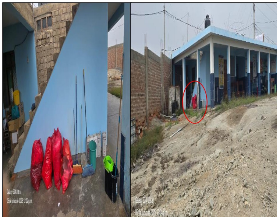
Fotografía n.º 10 No cuenta con almacén de residuos sólidos
