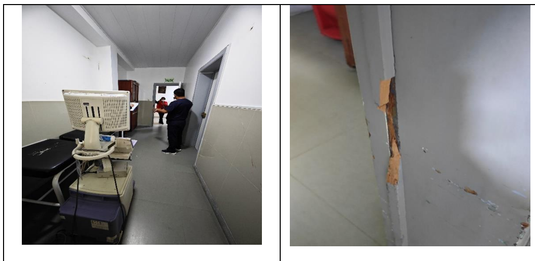
Servicio de Diagnostico por Imágenes donde se muestra ecógrafo desfasado y puerta averiada ocasionado por el ingreso de camillas de emergencia.
