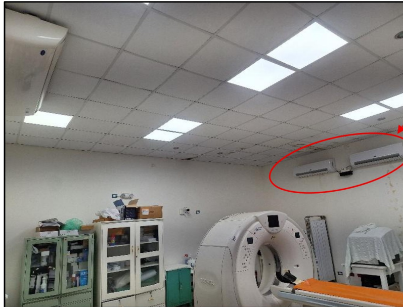
Imagen n.º 8 Sala de tomografía – Aire acondicionado inoperativo
