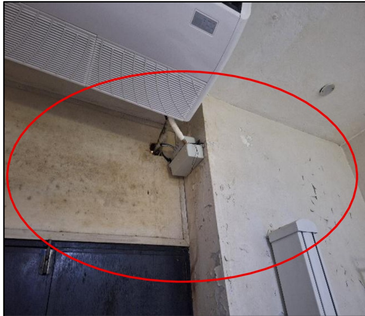
Imagen n.º 1 Sala de Rayos X – Desprendimiento de pintura
