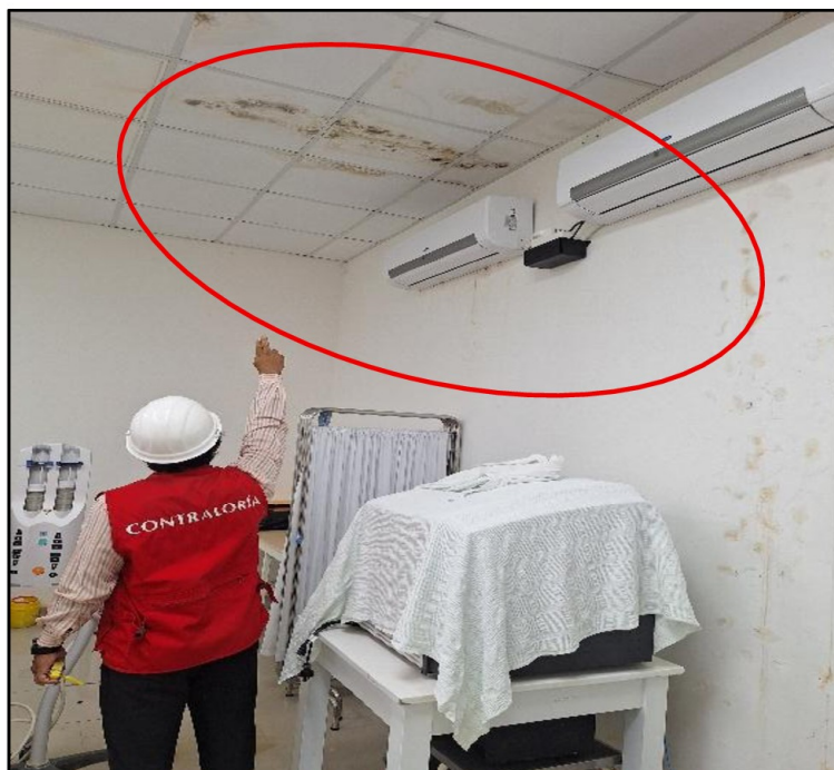
Imagen n.º 2 Sala de Tomografías – Presencia de hongos
