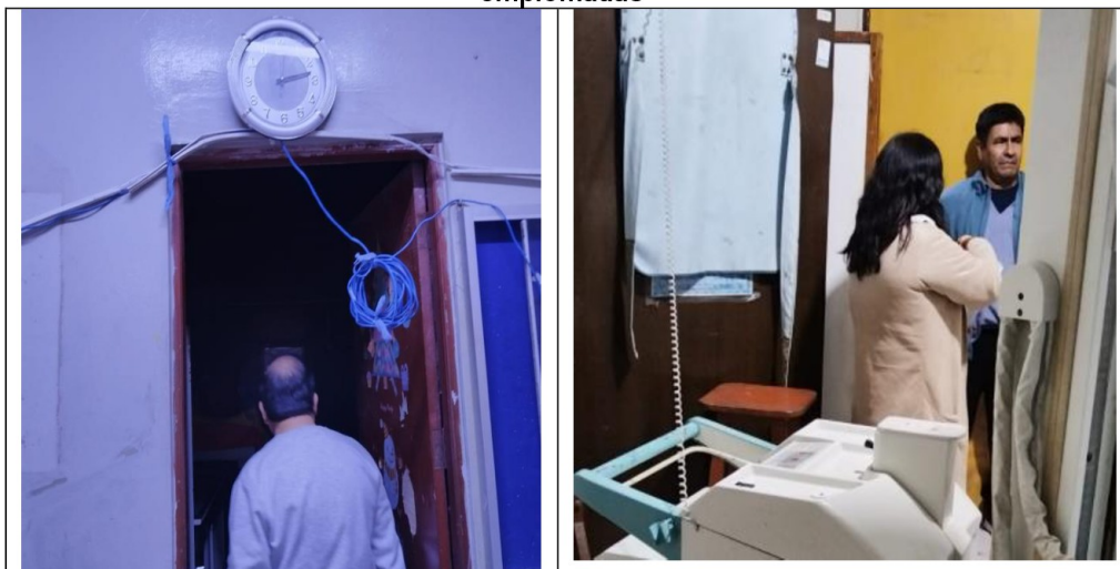
Una puerta de ingreso de madera normal al ambiente de Rayos X, donde se encuentran los equipos.
