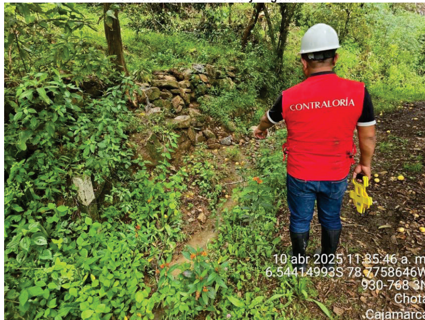
Imagen n.º 18 Cunetas con sedimento y vegetación
