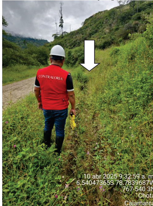
Imagen n.º 17 Cunetas con sedimento y vegetación
