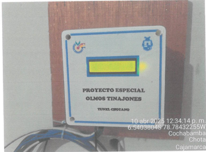
Imagen n.º18 Lectura tomada por la Comisión de Control con canal seco
