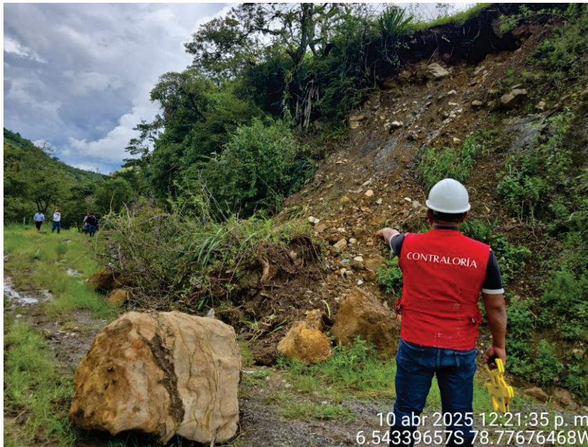
Imagen n.º 19 Derrumbes que impiden el libre acceso a las estructuras de captación y derivación
