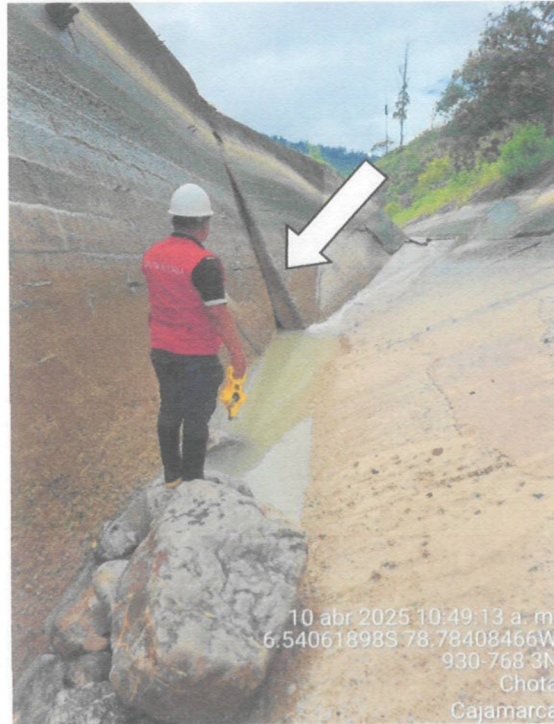
Imágenes n.ºs 20 y 21 Desplazamiento horizontal del despedrador
