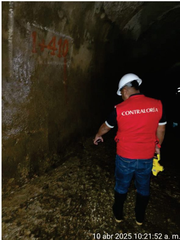
Imágenes n.ºs 10 y 11 Erosión en la losa de fondo del túnel n.º 3
