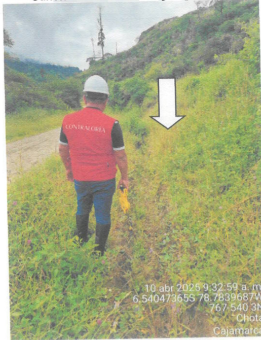
Imagen n.º 14 Cunetas con sedimento y vegetación
