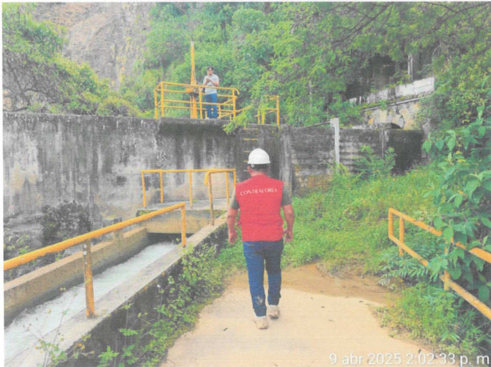
Imagen n.º 3 Falta de mantenimiento en las estructuras metálicas de la infraestructura de la boca de salida y presencia de vegetación al lado de las estructuras
