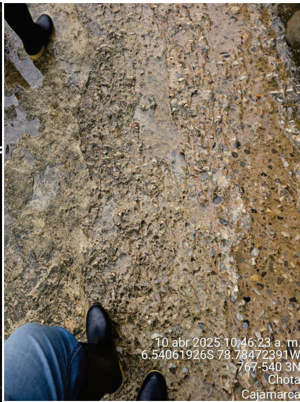
Imágenes n.ºs 10 y 11 Erosión en la losa de fondo del túnel n.º 3
