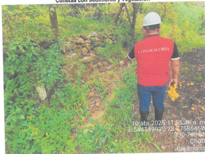
Imagen n.º 15 Cunetas con sedimento y vegetación
