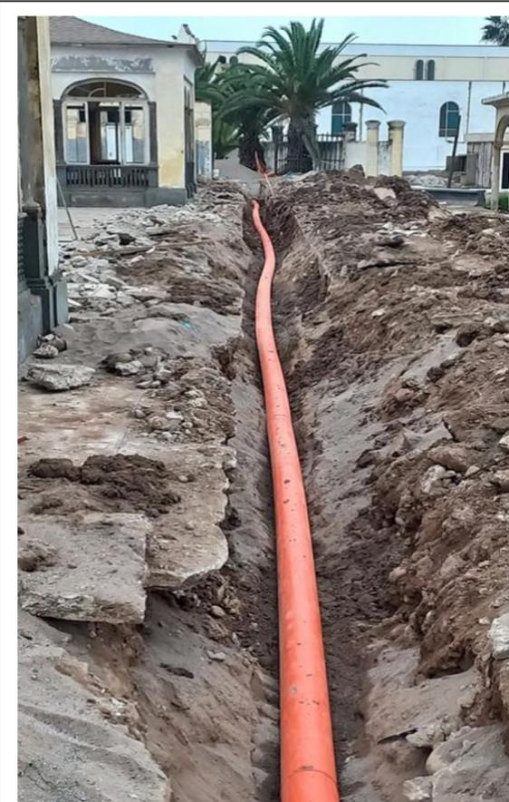
Vista de la tubería instalada entre los buzones Bz-15 y Bz-16 al final del tramo del colector principal, donde se aprecia la incorrecta alineación de la tubería debido a los salientes de la excavación de la zanja, según el asistente del residente de obra, único representante del contratista durante la inspección, confirmó que la pendiente en este tramo expuesto es aproximadamente del 0.6% en lugar de 2% indicado en el expediente técnico.
