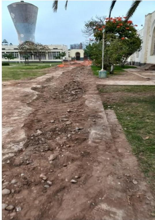
Vista similar a la anterior donde se aprecia trabajos de relleno compactado realizado con material propio no selecto o no zarandeado, no se tuvo evidencia de la presencia de zaranda estática para obtener el "material propio zarandeado tipo selecto" señalado en los análisis de costos unitarios.
