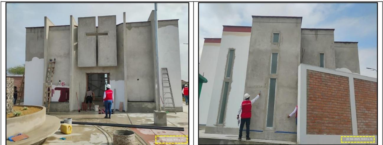
*Esta partida se encuentra inconclusa, debido a que falta pintar los muros de la fachada principal y muros de la parte posterior de la capilla, del mismo modo falta realizar el pintado con Pintura látex 2 manos en vigas (exteriores).*
