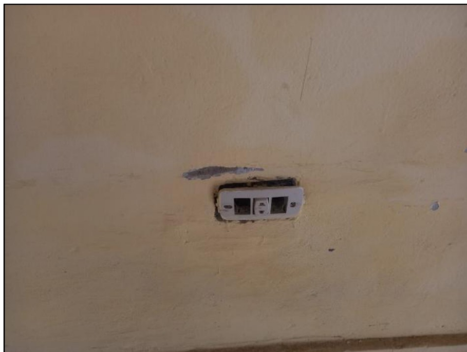
Imagen N° 27 Estado de tomacorriente en el Velatorio
