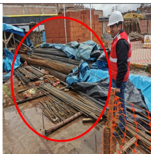
Fotografía n.º 27: acero corrugado de diferentes diámetros expuestos a la intemperie y presencia de óxido.
