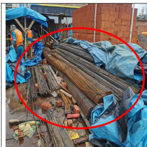
Fotografía n.º 26: Acero corrugado de diferentes diámetros expuestos a la intemperie y presencia de óxido.
