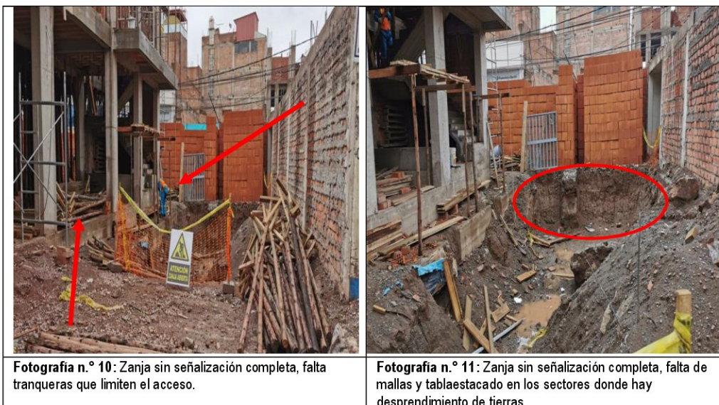
Fotografías n.ºs 10 y 11. Zanja con falta de señalización.
