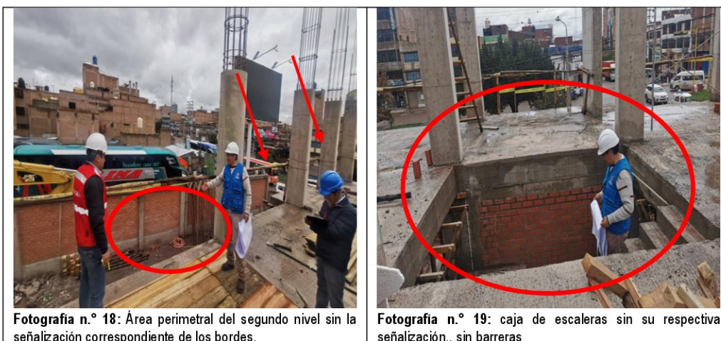
Fotografías n.ºs 18 y 19. Inadecuada señalización en la caja de escaleras
