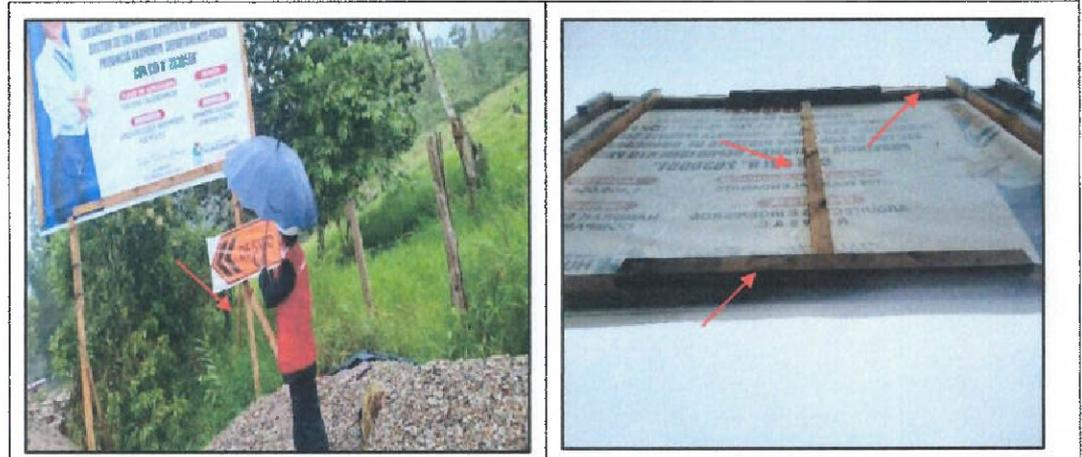
Las imágenes muestran el cartel de obra, contiene materiales distintos a los requeridos; además, no contiene la cimentación de concreto.
