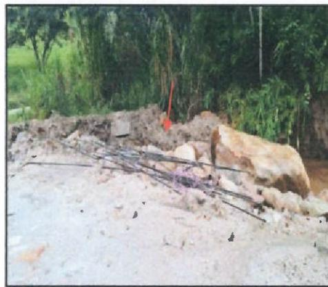
La imagen muestra el almacenamiento inadecuado del acero habilitado, los mismos que se encuentran a la intemperie y en contacto con el suelo.
