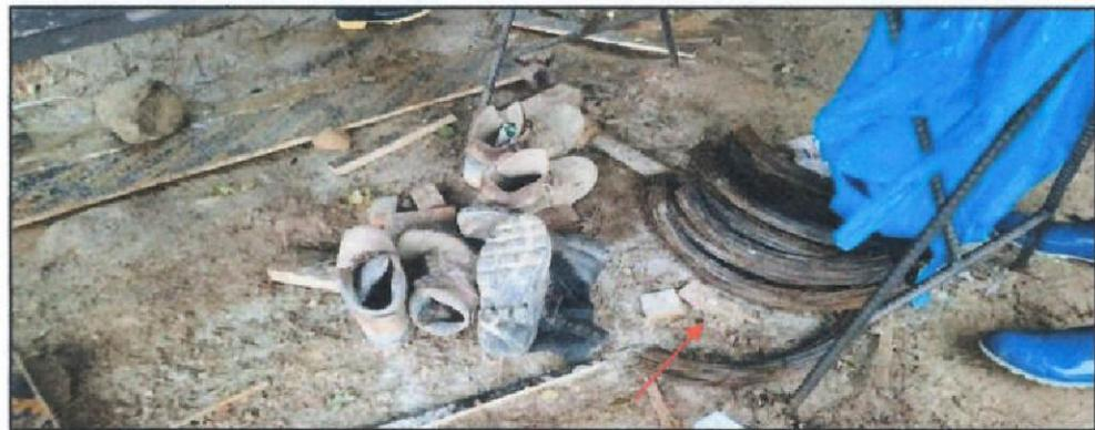
La imagen muestra el almacenamiento inadecuado del acero habilitado, los mismos que se encuentran a la intemperie y en contacto con el suelo.
