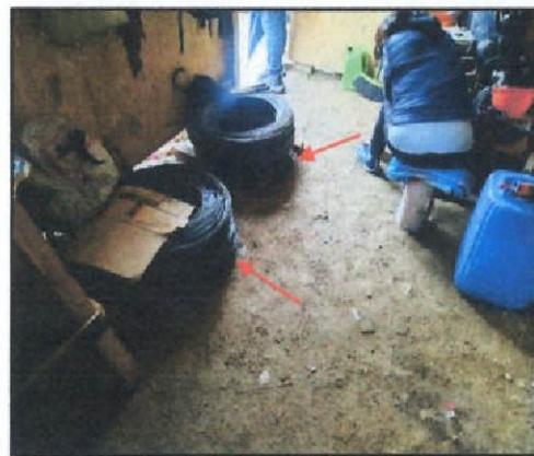
La imagen muestra el almacenamiento inadecuado de los rollos de alambre, los mismos que se encuentran en contacto con el suelo.
