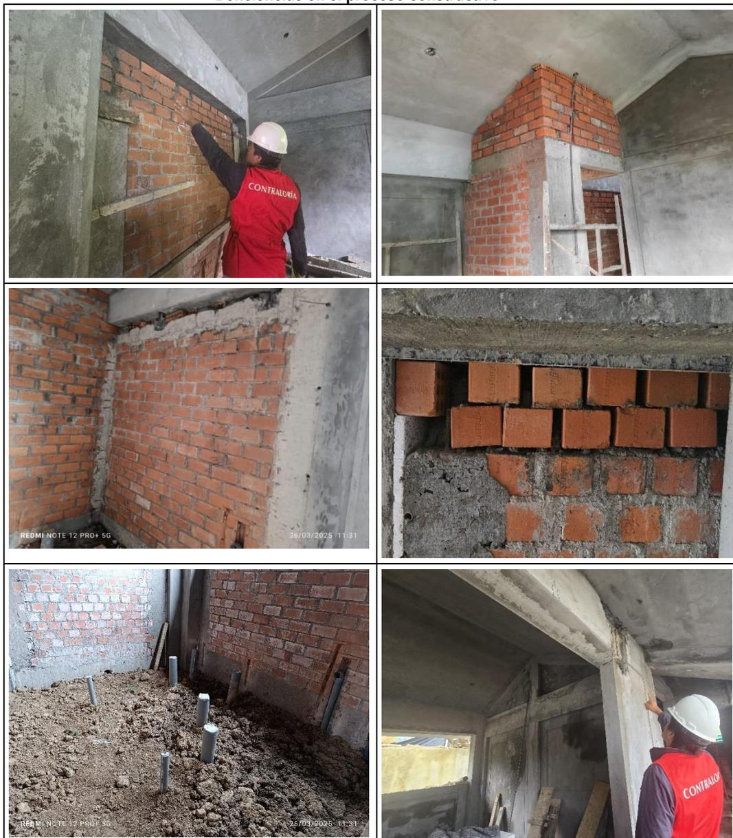
En las imágenes se puede observar una deficiente ejecución en los muros de albañilería, evidenciándose muros con columnetas que no cubren la altura del muro, muros sin viguetas de amarre, deficiente asentado de ladrillos, instalaciones sanitarias realizadas sobre material suelto y acero expuesto en la viga secundaria del segundo nivel del Módulo I (aulas).
