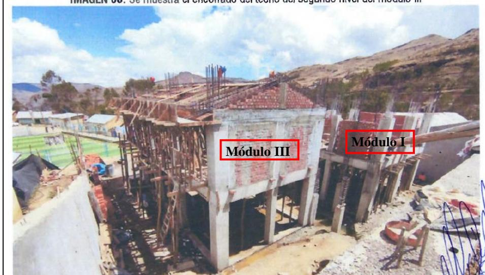
**IMAGEN 13:** Se inicia con la colocación de concreto estructural  $F'c=210\text{kg/cm}^2$  en el techo
