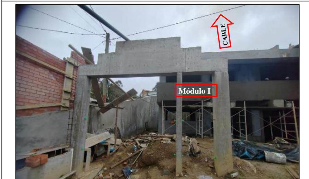
En las imágenes se puede observar el cable de baja tensión que atraviesa la obra, el cual fue la causal de la suspensión de obra por peligro inminente.
