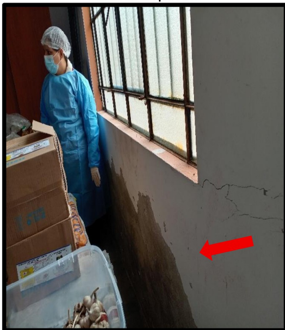
Salitre en las paredes
