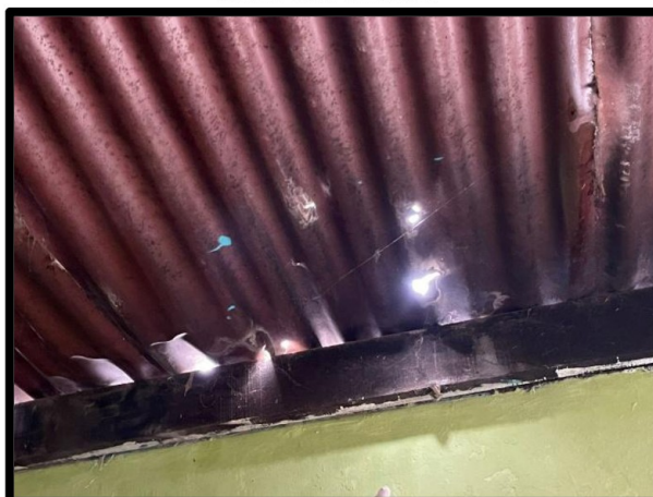
Techo con orificios
