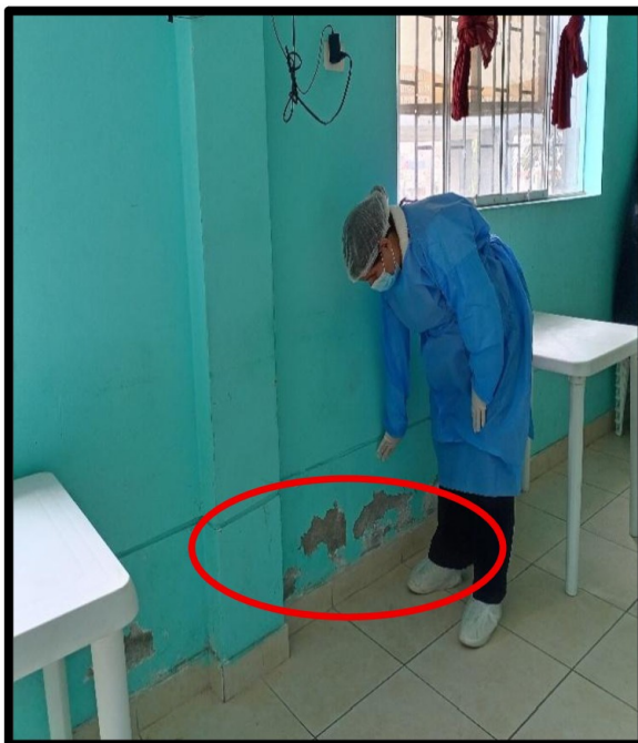
Salitre en las paredes
