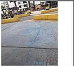
**FOTOGRAFÍA N.º 1 :** Se identifica las grillas y fierros en todo el paño de piso de concreto.
