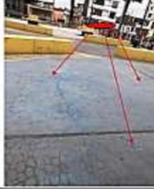
**FOTOGRAFÍA N.º 4 :** Se identifica el pavimento de grillas y fierros en todo el paño de piso de concreto estampado.
