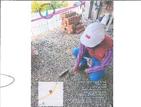
**Fotografía n.º 149:** Se verificó, el agua utilizada para la mezcla del tarrajeo de muros del segundo nivel con impurezas.
