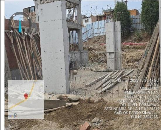
**Fotografía n.º 154:** Se verificó, pies derechos y tablas utilizados en los encofrados almacenados en esta área, sin restricción y señalización.
