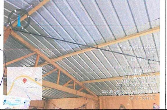
**Fotografía n.º 63:** Se verificó, cabezas de clavos expuestos en los bastidores verticales al interior del módulo.
