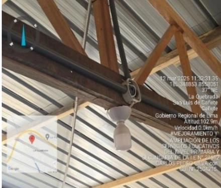
**Fotografía n.º 53:** Se verificó, que la tubería eléctrica se encuentra sujetado con cintillos de plástico a la vigueta de madera.
