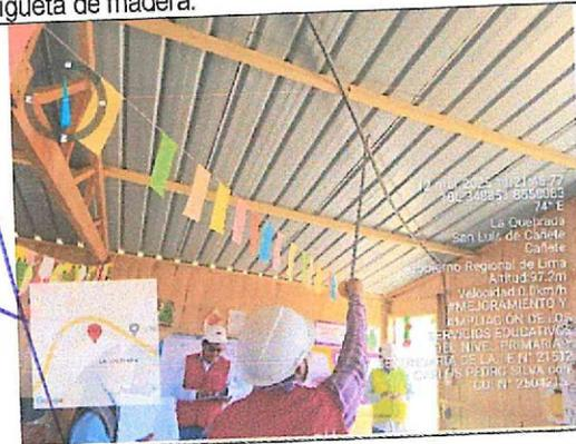
Fotografía n.º 43: Se verificó caja eléctrica octagonal sin tapa, además del detalle central del tijeral de madera del cuarto módulo.
