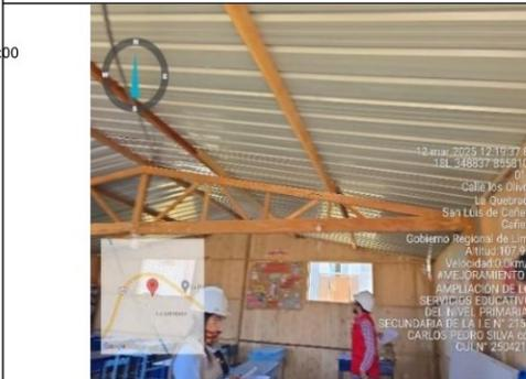
**Fotografía n.º 102:** Se verificó, que no se instaló canaletas pluviales para el drenaje de lluvias.
