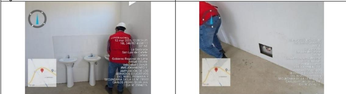
**Fotografías n.ºs 114 y 115:** Se verificó, fisura en la losa de concreto al interior y exterior del módulo.
