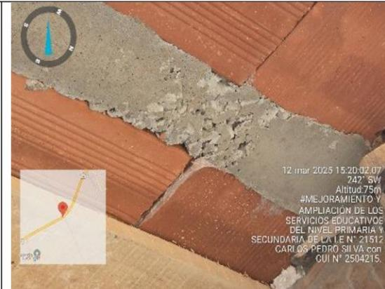
**Fotografías n.ºs 138 y 139:** Se verificó, columna tipo C3 de 0.25 x 0.50m, con presencia de segregación del concreto.
