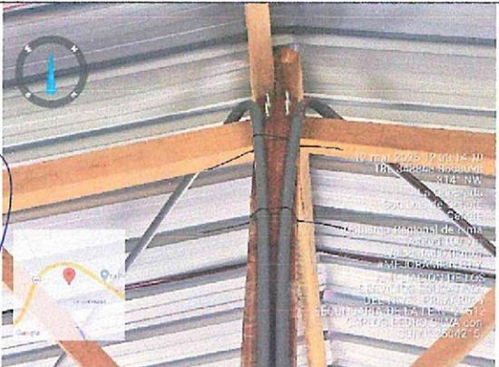
**Fotografía n.º 86:** Se verificó caja eléctrica octagonal sin tapa, además del detalle central del tijeral de madera del tercer módulo.
