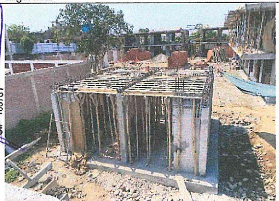
**Fotografía n.º 172:** Se verifica varillas de acero expuesto sin protección.
