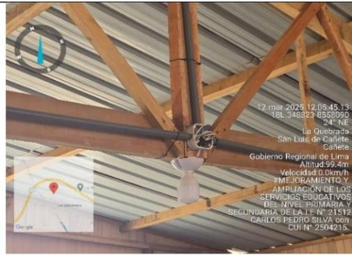
**Fotografía n.º 93:** Se verificó, que la tubería eléctrica se encuentra sujeta con cintillos de plástico a la vigueta.
