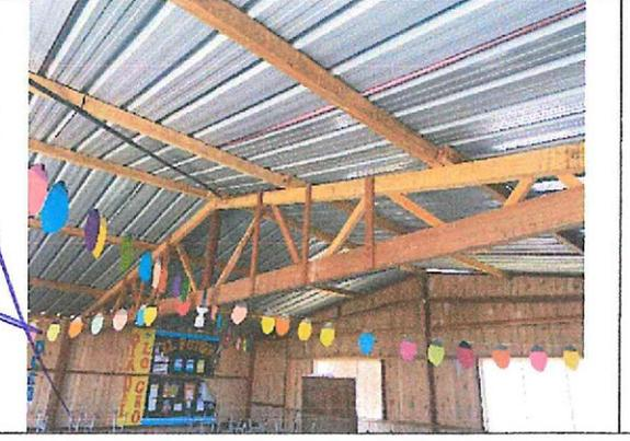
**Fotografía n.º 67:** Se verificó que la columna de madera que sostiene el tijeral, separado del bastidor horizontal y verticales.
