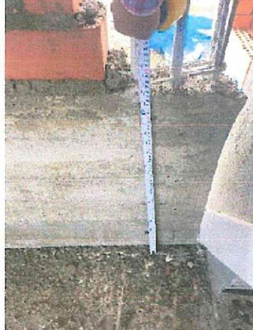
**Fotografía n.º 124:** Se verificó, una esquina de una columna del primer piso, desprendimiento de concreto en la columna del primer piso.
