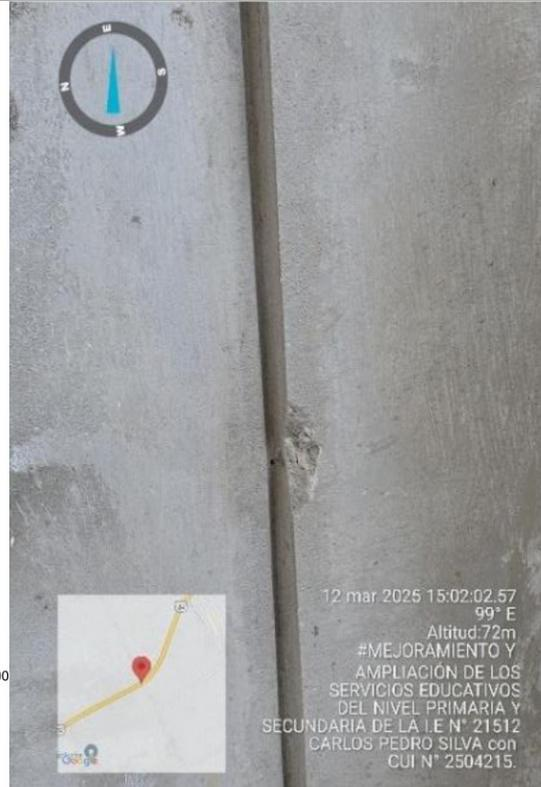
**Fotografía n.º 125:** Se verificó, tubería eléctrica de PVC, expuestas sin protección.
