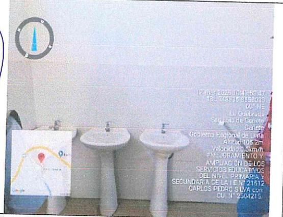
**Fotografía n.º 8:** Se constató, tubería flexible utilizada para el desagüe de los lavamanos. No se evidenció la instalación de trampas para desagüe.
