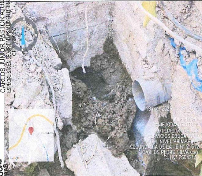
**Fotografía n.º 17:** Se evidenció, que la tubería de desagüe se encuentra en funcionamiento, asimismo se verifica estancamiento de las aguas servidas. A un lado del área de "Comedor" en ejecución.
