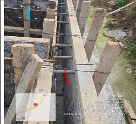
**Fotografía n.º 165:** Se verifica presencia de oxido en las varillas de acero izados.
