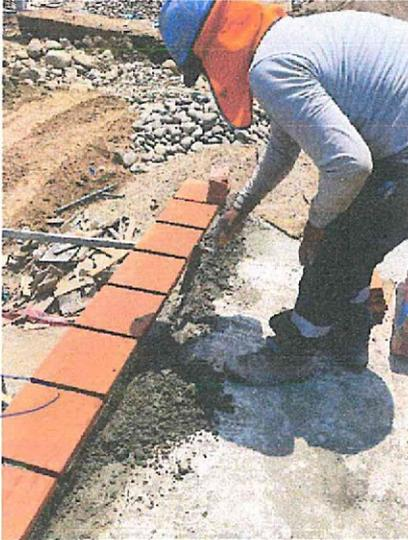
**Fotografía n.º 65:** Se verificó, la colocación del ladrillo pastelero.
