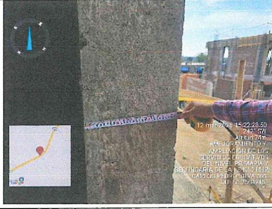
Fotografías n.ºs 140 y 145: Se verificó, en las columnas, presencia de segregación del concreto.
