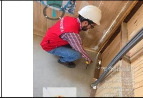
**Fotografía n.º 105:** Se verificó, fisura en la losa de concreto al interior del módulo.
