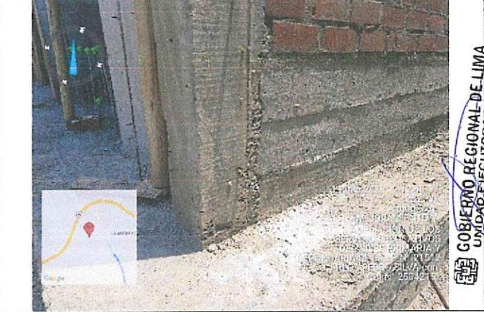
**Fotografía n.º 57:** Se verificó el espesor de la platea de cimentación de 45 cm. Aproximadamente.
