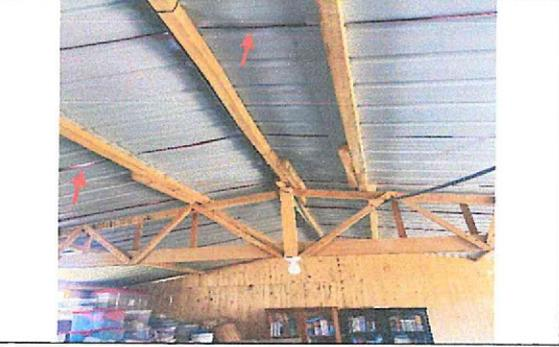
Fotografía n.º 73: Se verificó, que la tubería eléctrica se encuentra sujeta con cintillos de plástico a la vigueta de madera.
