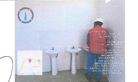
Fotografía n.º 113: Se verificó, instalación de la llave de paso sin tapa.
