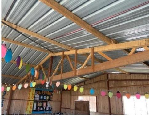
**Fotografía n.º 67:** Se verificó que la columna de madera que sostiene el tijeral, separado del bastidor horizontal y verticales.
