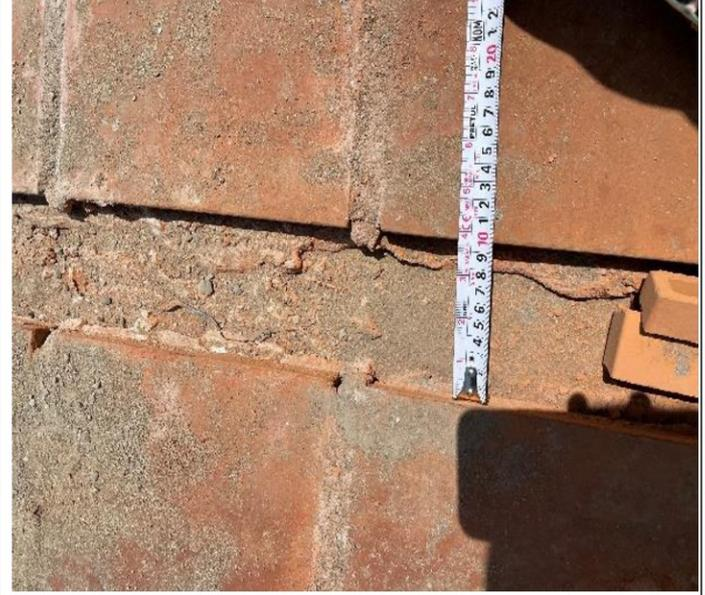
**Fotografía n.º 32:** Se verificó, montante de pvc de  $\varnothing=3"$ , expuesto sin protección, además se encuentra pendiente de eliminar excesos de concreto en la sección de la cuneta.
