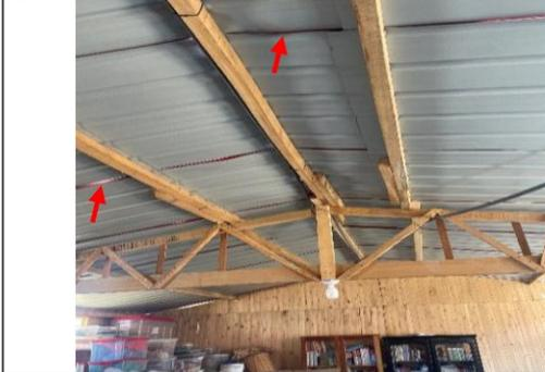
**Fotografía n.º 73:** Se verificó, que la tubería eléctrica se encuentra sujeta con cintillos de plástico a la vigueta de madera.
