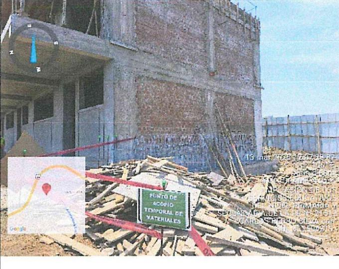
**Fotografía n.º 42:** Se verificó, materiales utilizados para el encofrado en desuso, acopiados en el primer nivel. (orden y limpieza)
