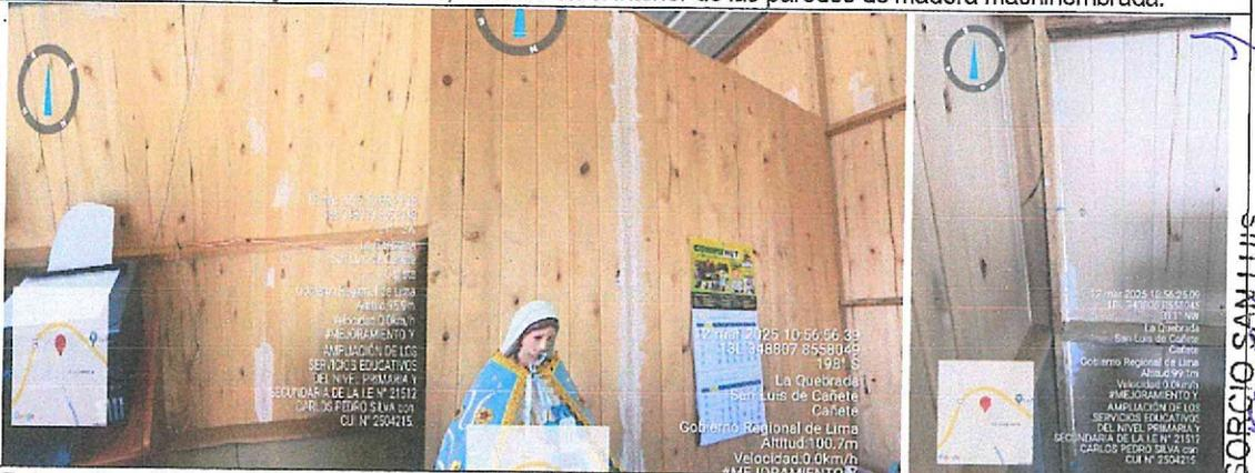
Fotografía n.º 25: Se verificó, que la tubería eléctrica se encuentra sujeta con cintillos de plástico a la viga de madera.
