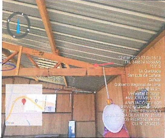
**Fotografía n.º 92:** Se verificó caja eléctrica octagonal sin tapa, además del detalle central de la unión del tijeral de madera del cuarto módulo.
