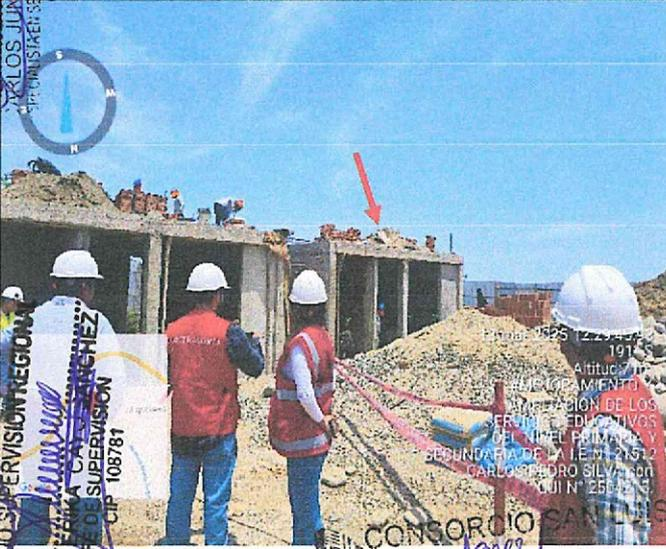
**Fotografía n.º 67:** Se verificó, agregado y bolsas de cemento en contacto con el suelo y sin cubierta superficial.
