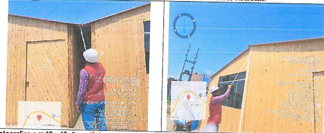
Fotografías n.ºs 18 y 19: Se verificó, que no se instaló canaletas pluviales para el drenaje de lluvias.
