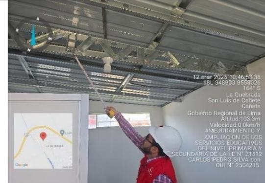
**Fotografía n.º 10:** Se verificó caja eléctrica octagonal sin tapa.
