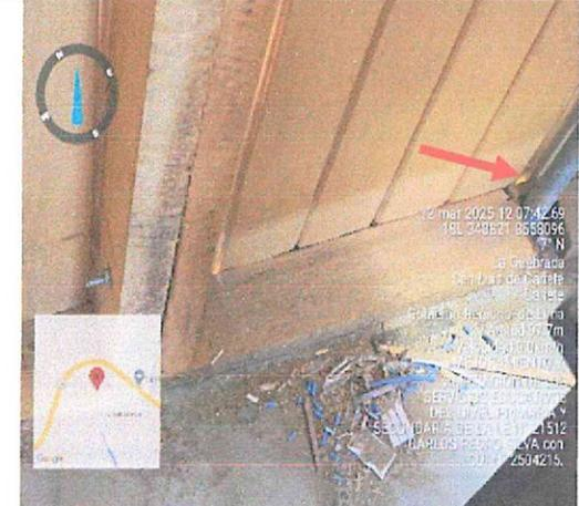
**Fotografía n.º 95:** Se verificó, fisura en la losa de concreto al exterior del módulo.
