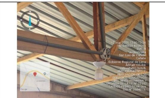
**Fotografías n.ºs 87 y 88:** Se verificó, que la brida inferior del tijeral de madera, es de 15 cm x 5 cm.
