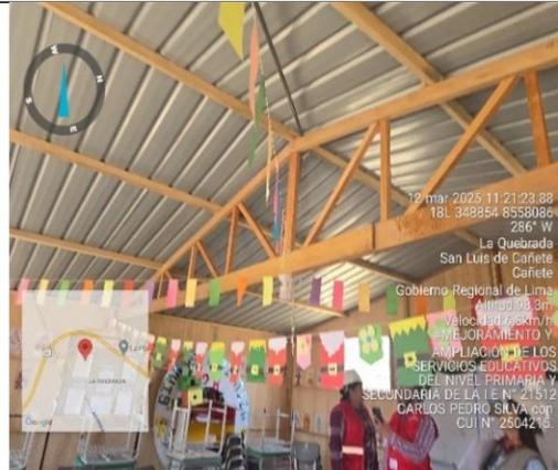
**Fotografía n.º 42:** Se verificó, que la tubería eléctrica se encuentra amarrada con cintillos de plástico a la vigueta de madera.
