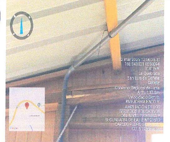
**Fotografía n.º 94:** Se verificó, que el bastidor horizontal que está en contacto con la losa, no muestra continuidad, asimismo no se encuentra fijado.
