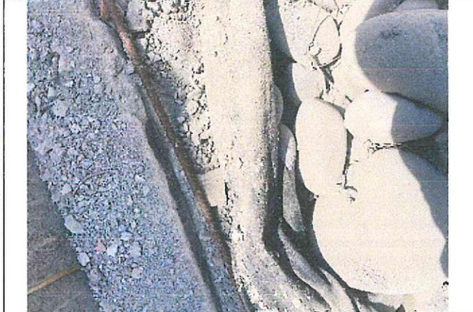
**Fotografía n.º 56:** Se verificó presencia de segregación en la columna.
