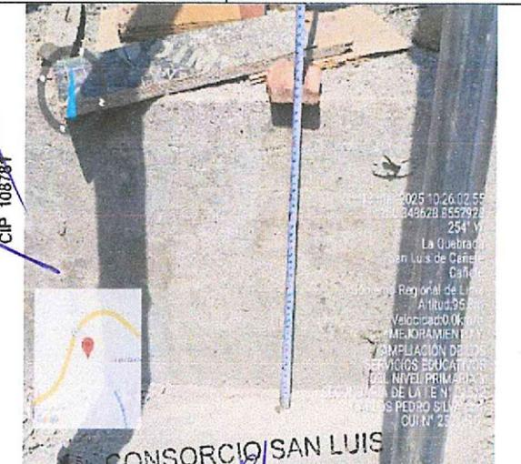
**Fotografía n.º 4:** Se evidenció que las varillas de acero se encuentran expuestas y sin protección.
