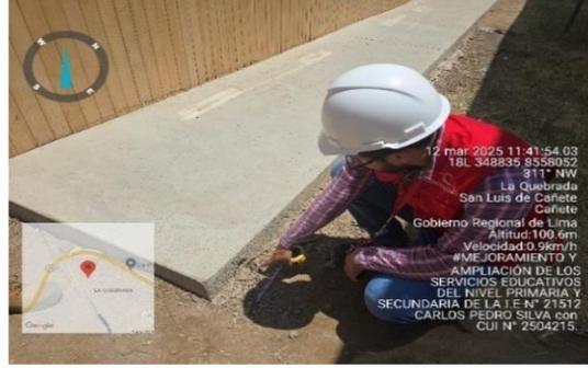
**Fotografía n.º 60:** Se verificó, rebabas del concreto de la losa de estos módulos, pendientes de eliminación.
