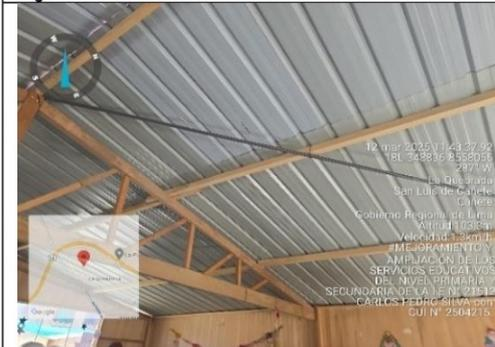
**Fotografía n.º 63:** Se verificó, cabezas de clavos expuestos en los bastidores verticales al interior del módulo.
