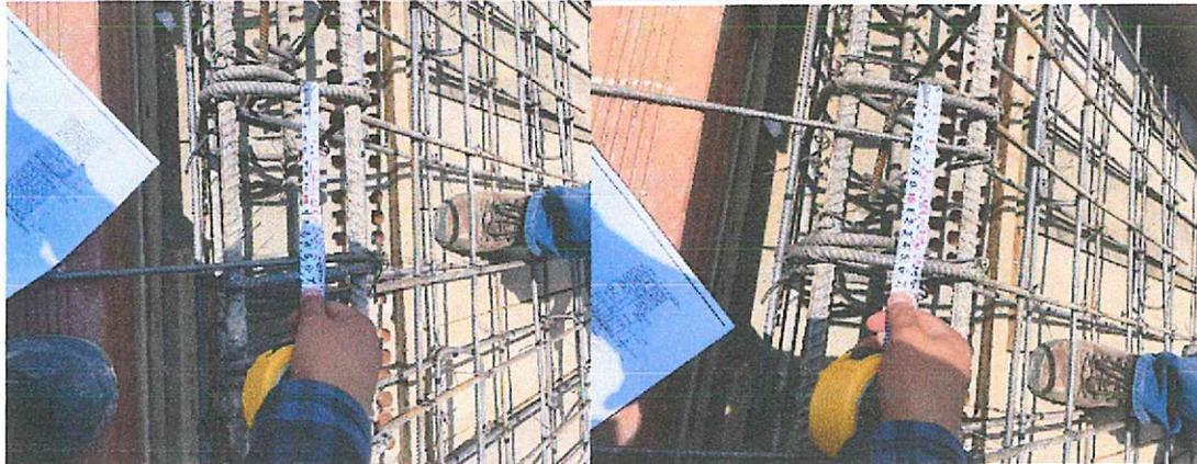
**Fotografía n.º 39:** Se verificó, en la losa del pasadizo, que la malla del acero de temperatura pendiente de ser colocados al centro del espesor de la losa proyectada.
