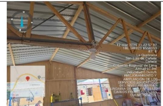
**Fotografía n.º 62:** Se verificó, que la tubería eléctrica se encuentra amarrada con cintillos de plástico a la vigueta de madera.
