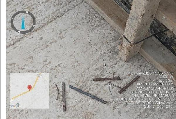
**Fotografía n.º 163:** Se verifica el encofrado del sobrecimiento, con cara interior desgastada.
