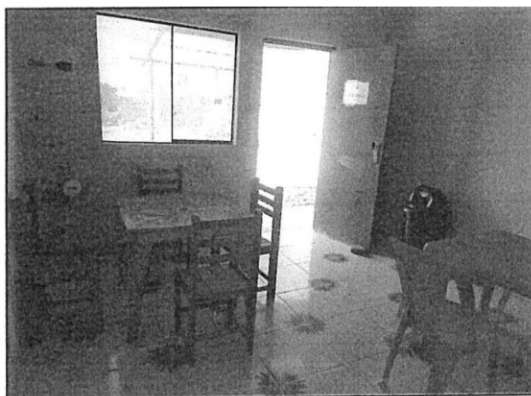
Verificación del Comedor
