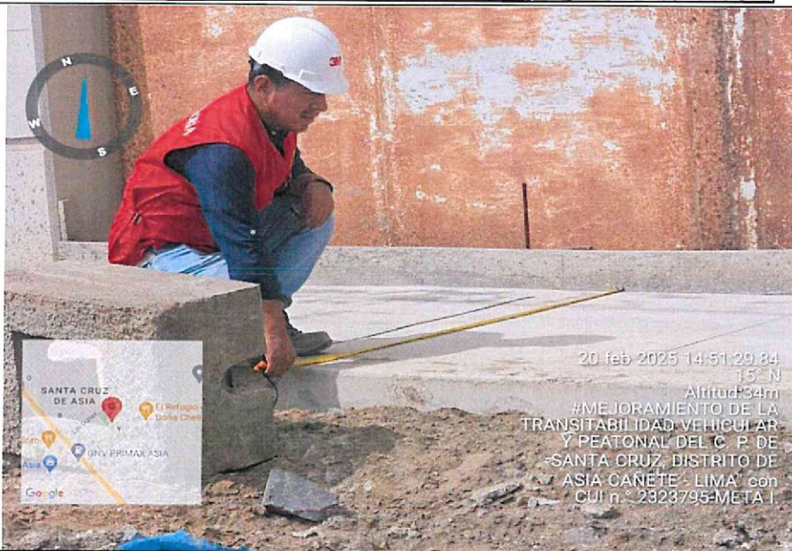
Imagen n.º 46 Se verificó el ancho de vereda (1,50 m.)
