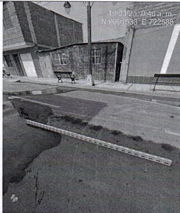
**Vista fotográfica N.º 131:** Verificación de depresiones de la vía, mediante la comprobación con una regla de tres (3) metros de forma paralela a la vía, carril izquierdo de la calzada, CA. Spelucín (tramo CA Manuel Arévalo y Antenor Orrego), coordenadas N 9091533 E 722588.
