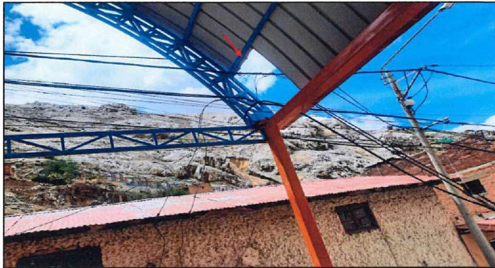
Las fotografías muestran interferencia de cables telefónicos y cables eléctricos con la cobertura metálica del campo deportivo, generando el riesgo a causar posibles descargas eléctricas que puedan afectar la integridad física del personal obrero, administrativo y técnico.
