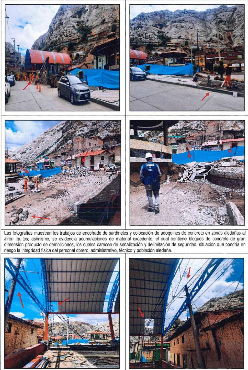
Las fotografías muestran los trabajos de encofrado de sardineles y colocación de adoquines de concreto en zonas aledañas al Jirón Iquitos; asimismo, se evidencia acumulaciones de material excedente, el cual contiene bloques de concreto de gran dimensión producto de demoliciones, los cuales carecen de señalización y delimitación de seguridad, situación que pondría en riesgo la integridad física del personal obrero, administrativo, técnico y población aledaña.
