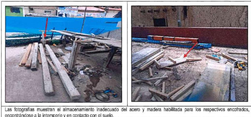
De las fotografías expuestas, se advierte que el almacenamiento y conservación de los materiales de construcción de obra, no se efectúan conforme lo señala el sub numeral 3.7 Almacenamiento de Materiales del Capítulo 3 – Materiales de la NORMA E-060, Concreto Armado del RNE, que establece:
