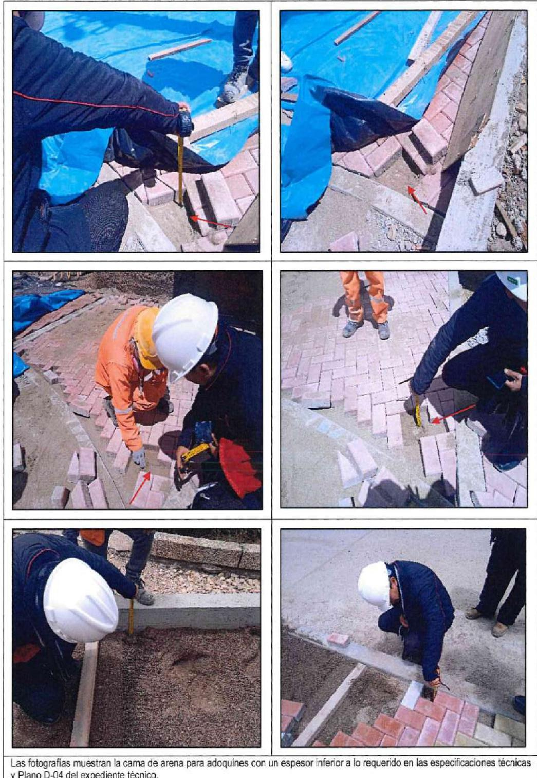
De lo expuesto, se muestra que la partida 02.02.02.04 CAMA DE ARENA PARA ADOQUINES (M2), se viene ejecutando sin cumplir con lo establecido en las especificaciones técnicas y Plano D-04 (Detalle de Pisos Adoquinados) del expediente técnico de obra, el cual indica que la capa y/o cama de arena deber ser 2" de espesor.
