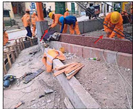
Las fotografías muestran al personal obrero con implementos de seguridad incompletos (Guantes y lentes de seguridad), para las labores de acabado de sardineles con granito lavado, encofrado de sardineles y banca de concreto; así como, trabajo de demolición de concreto existente.
