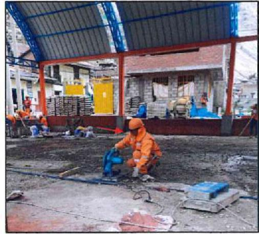
Las fotografías muestran al personal obrero con implementos de seguridad incompletos tales como: Lentes y guantes de seguridad, para las labores de habilitación de acero y madera para la ejecución de la obra.
