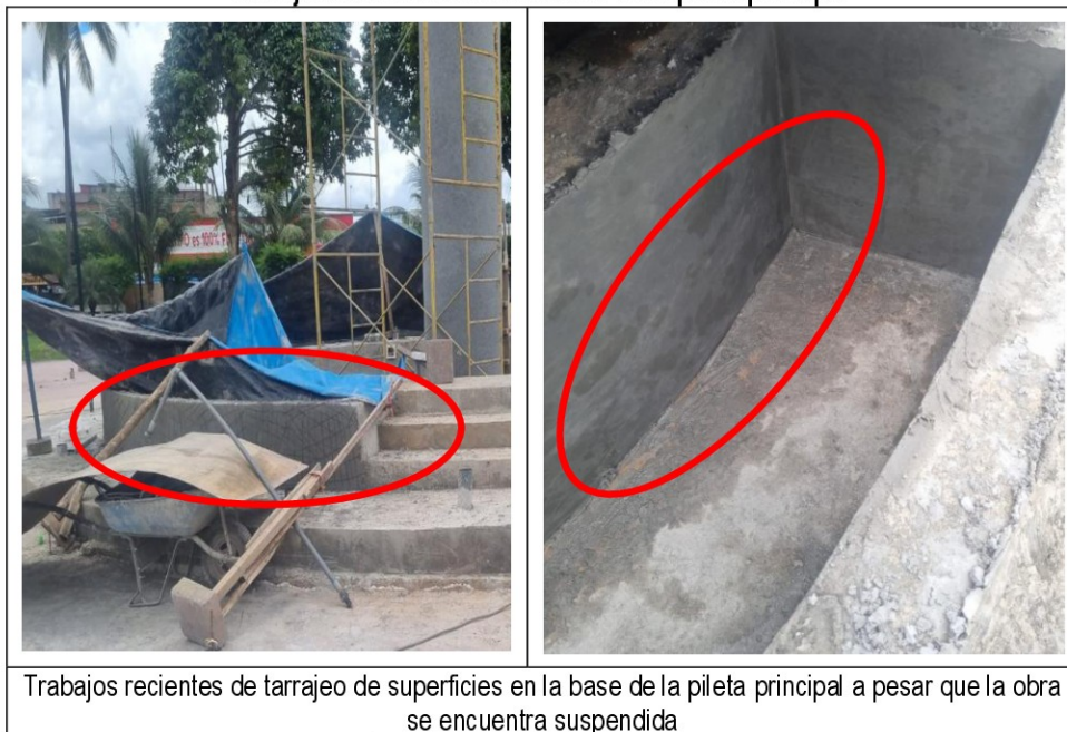
Imágenes n.ºs 9 y 10 Trabajos de acabados en la base de la pileta principal
