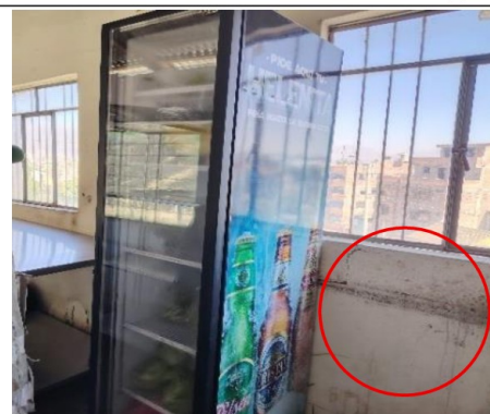
Se observa desgaste en pintura de pared
