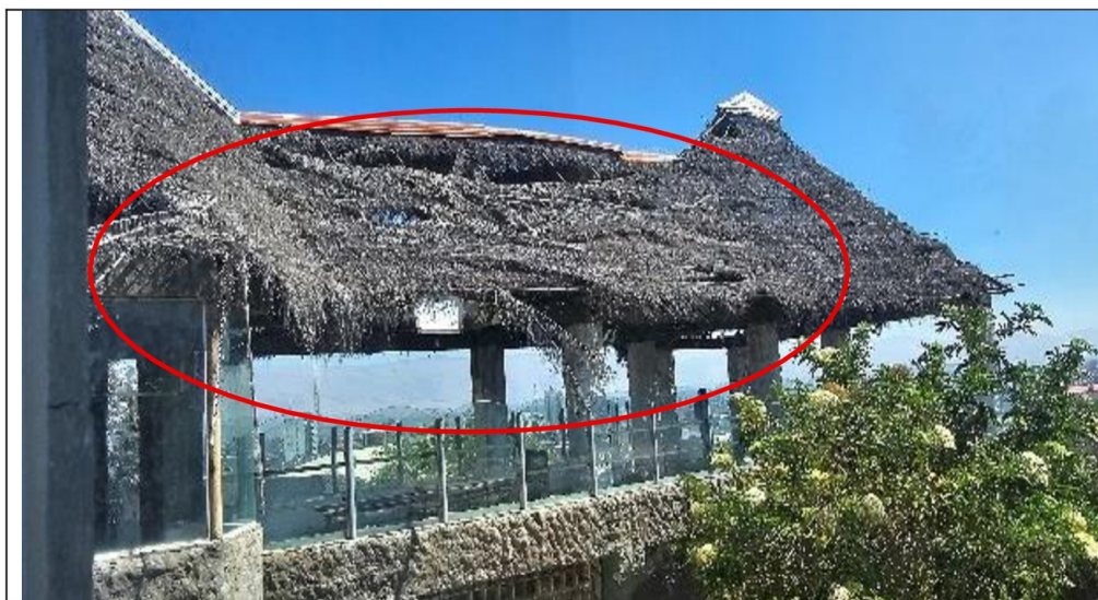
Techos de paja en mal estado de conservación, presenta agujeros y pérdida de material con la que fue tapado.
