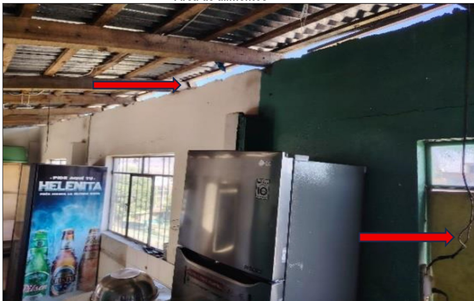
Se observa abertura entre techo y pared, así como el cable de conexión colgado.
