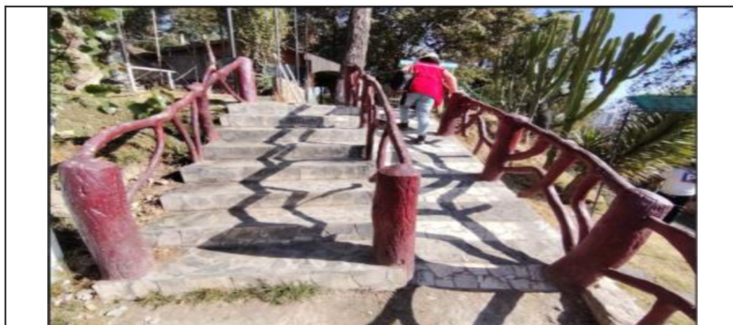
Fotografía 28: Se evidencia desgaste en los peldaños de alta contrahuella, y una rampa con pendiente pronunciada
