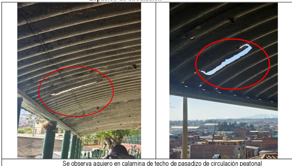
Se observa agujero en calamina de techo de pasadizo de circulación peatonal
