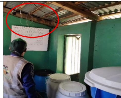
Se observa la presencia de cables colgados de las correas de madera del techo para conexión de cámara de seguridad
