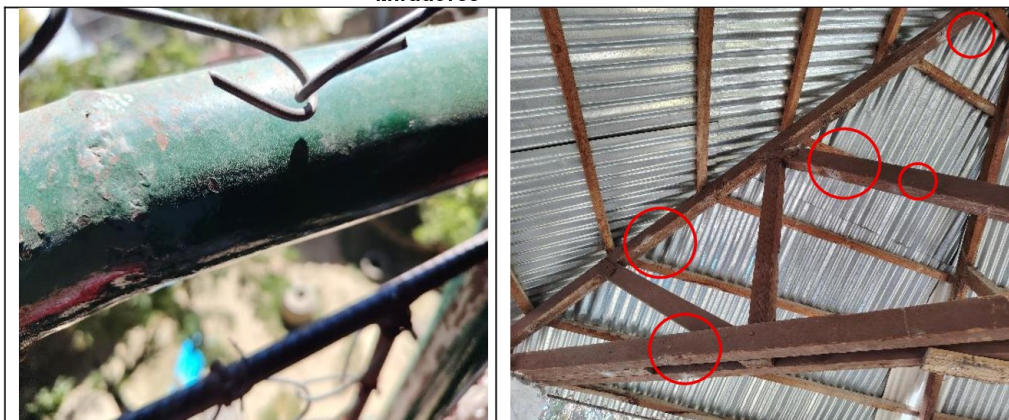
Se observan manchas blancas en maderas de estructuras que soportan el techo de calamina
