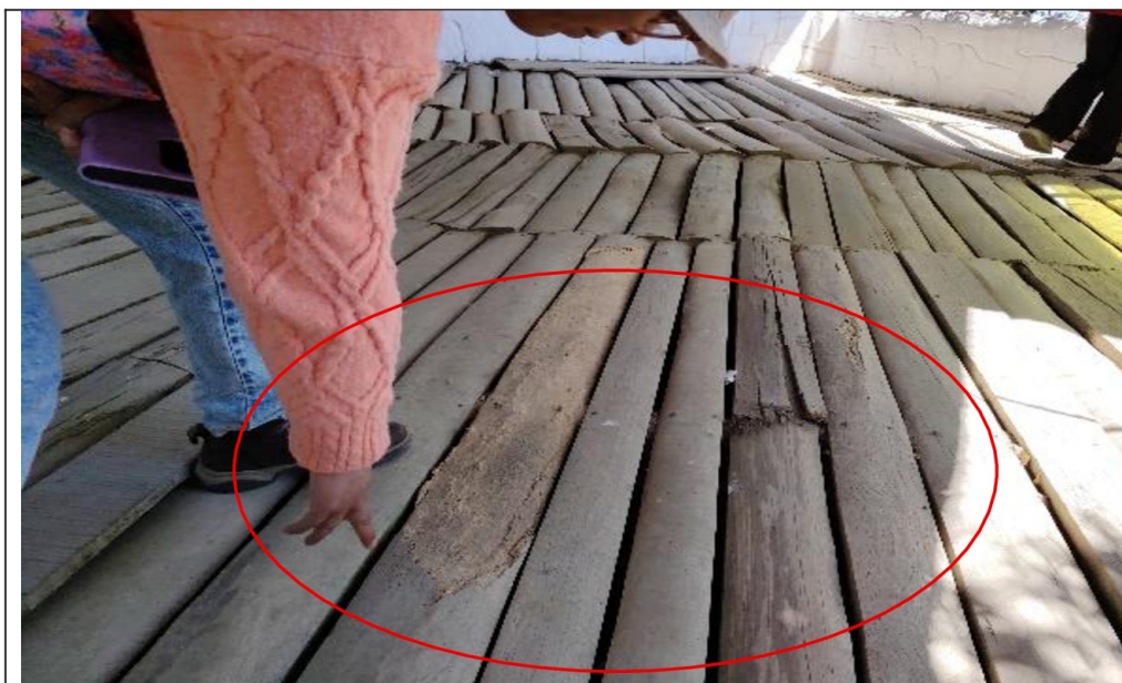
Se observan tablonces de madera antiguos, deteriorados y sin mantenimiento en piso.
