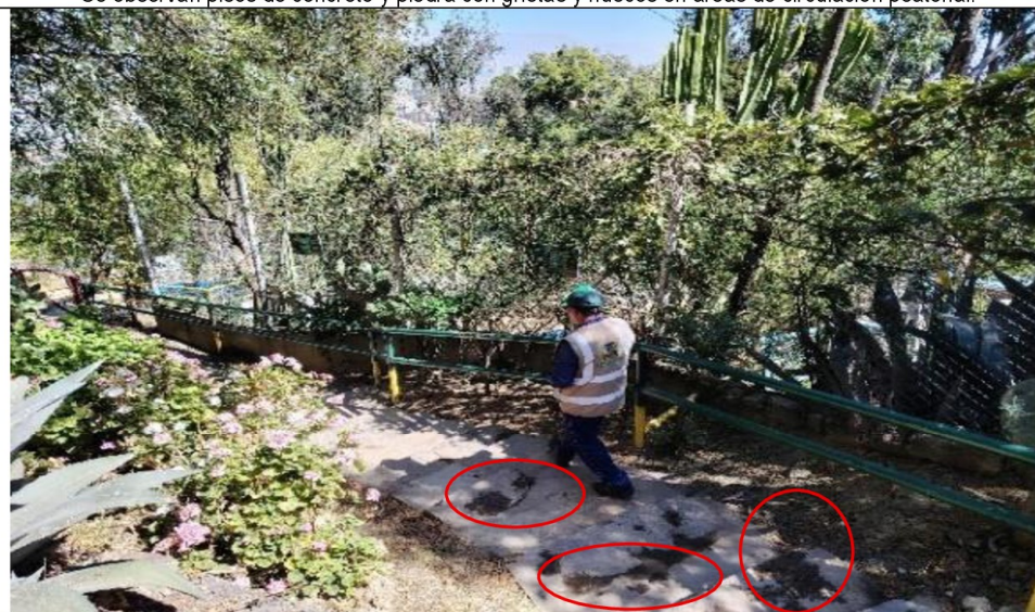
Se observa presencia de tierra y musgo en graderías por falta de mantenimiento y limpieza
