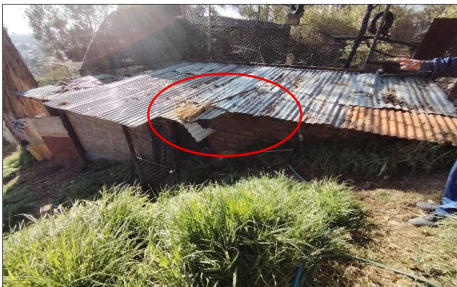
Dormidero cubierto con algunas calaminas en mal estado y una escoba.
