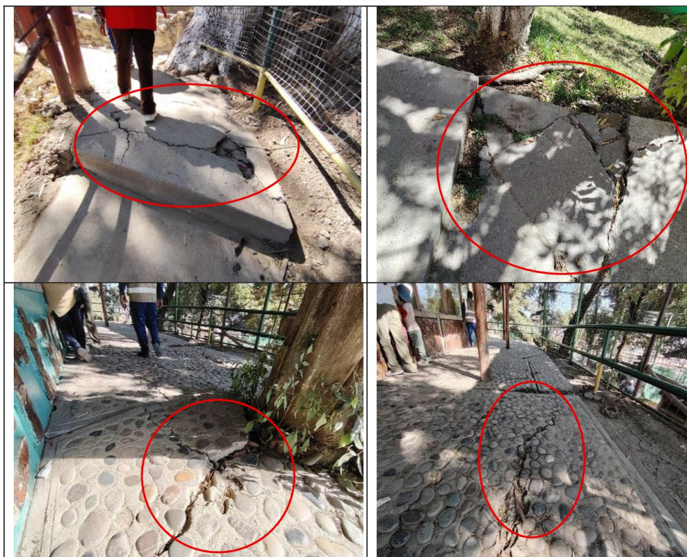
Se observan pisos de concreto y piedra con grietas y huecos en áreas de circulación peatonal.
