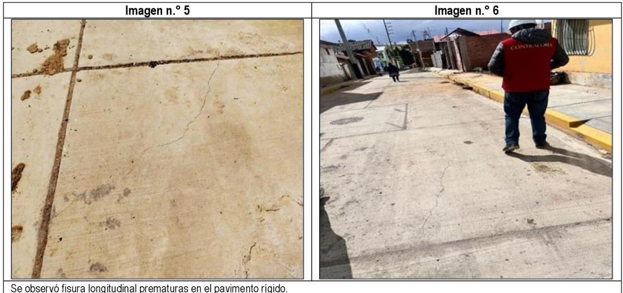
Se observó fisura longitudinal prematuras en el pavimento rígido.
