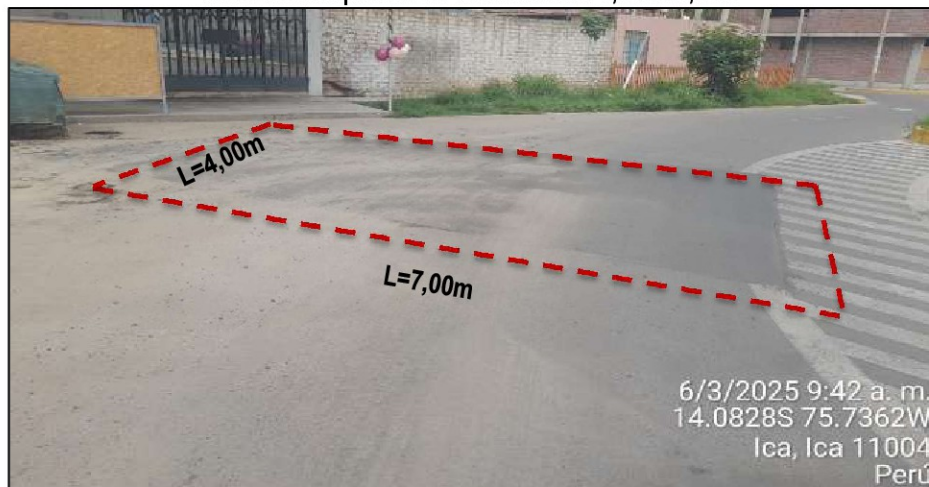
Imagen N° 20 Pavimento repuesto de dimensiones 4,00mx7,00m
