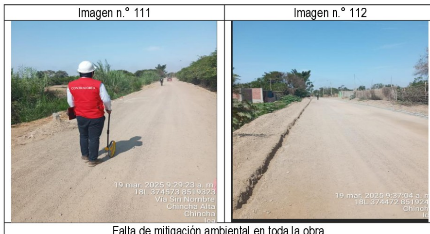
Falta de mitigación ambiental en toda la obra.
