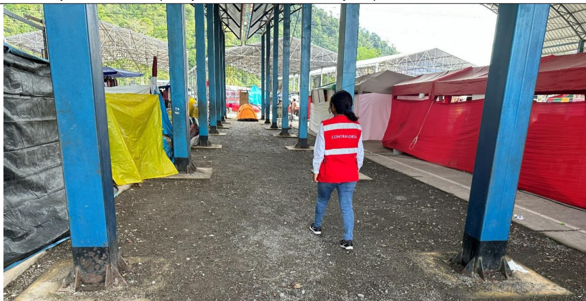
Base metálica de la columna cuadrada, los pernos de anclaje y la parte inferior de la columna en estado de corrosión, y tubería de PVC que baja de las canaletas de drenaje de pluvial, en la cobertura metálica 3
