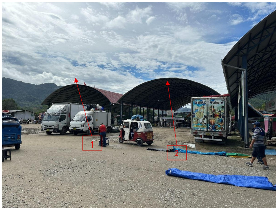
Cobertura metálica 1 y 2
