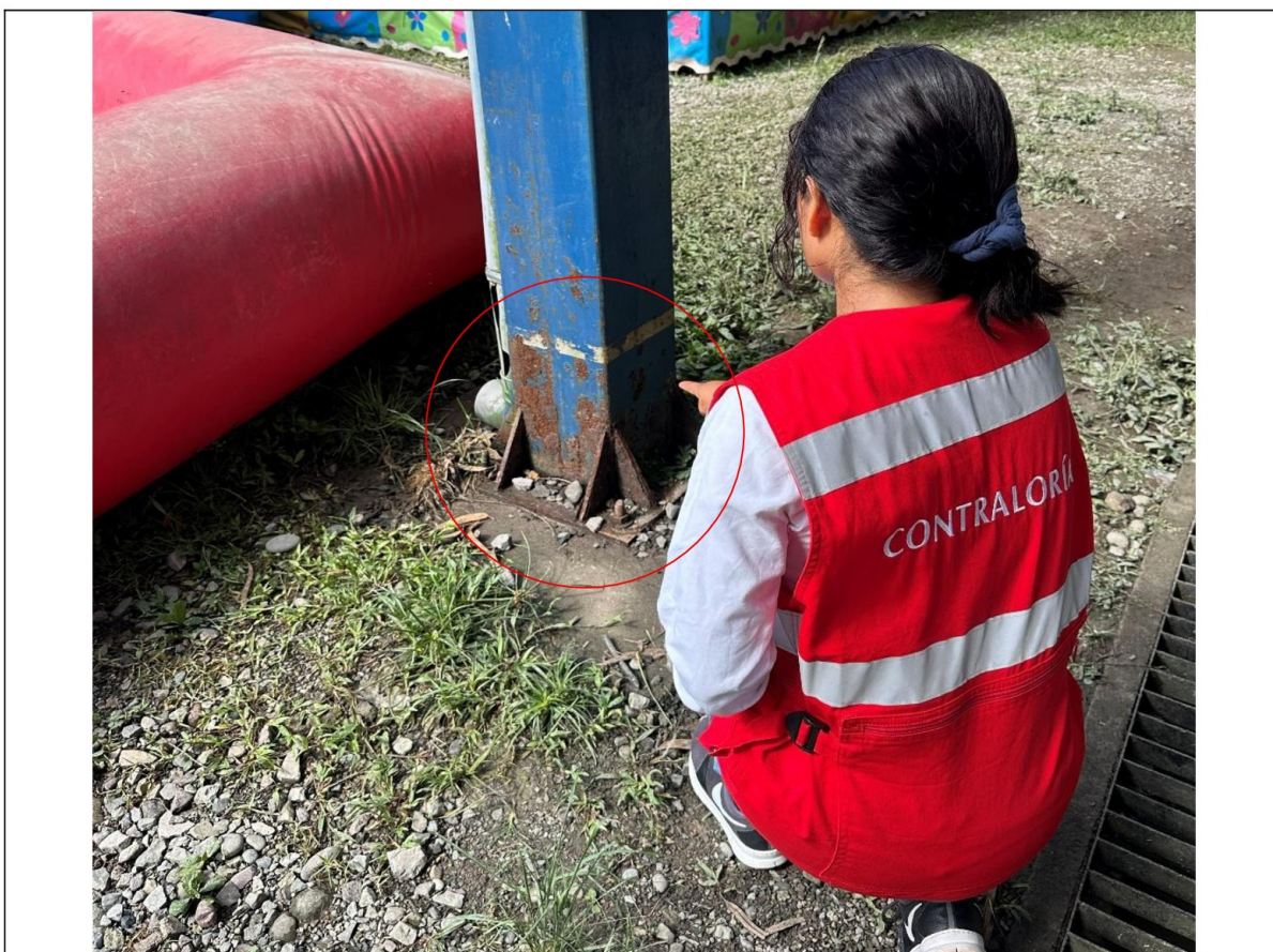
Base metálica de la columna cuadrada, los pernos de anclaje y la parte inferior de la columna en estado de corrosión, y tubería de PVC que baja de las canaletas de drenaje de pluvial, en la cobertura metálica 3
