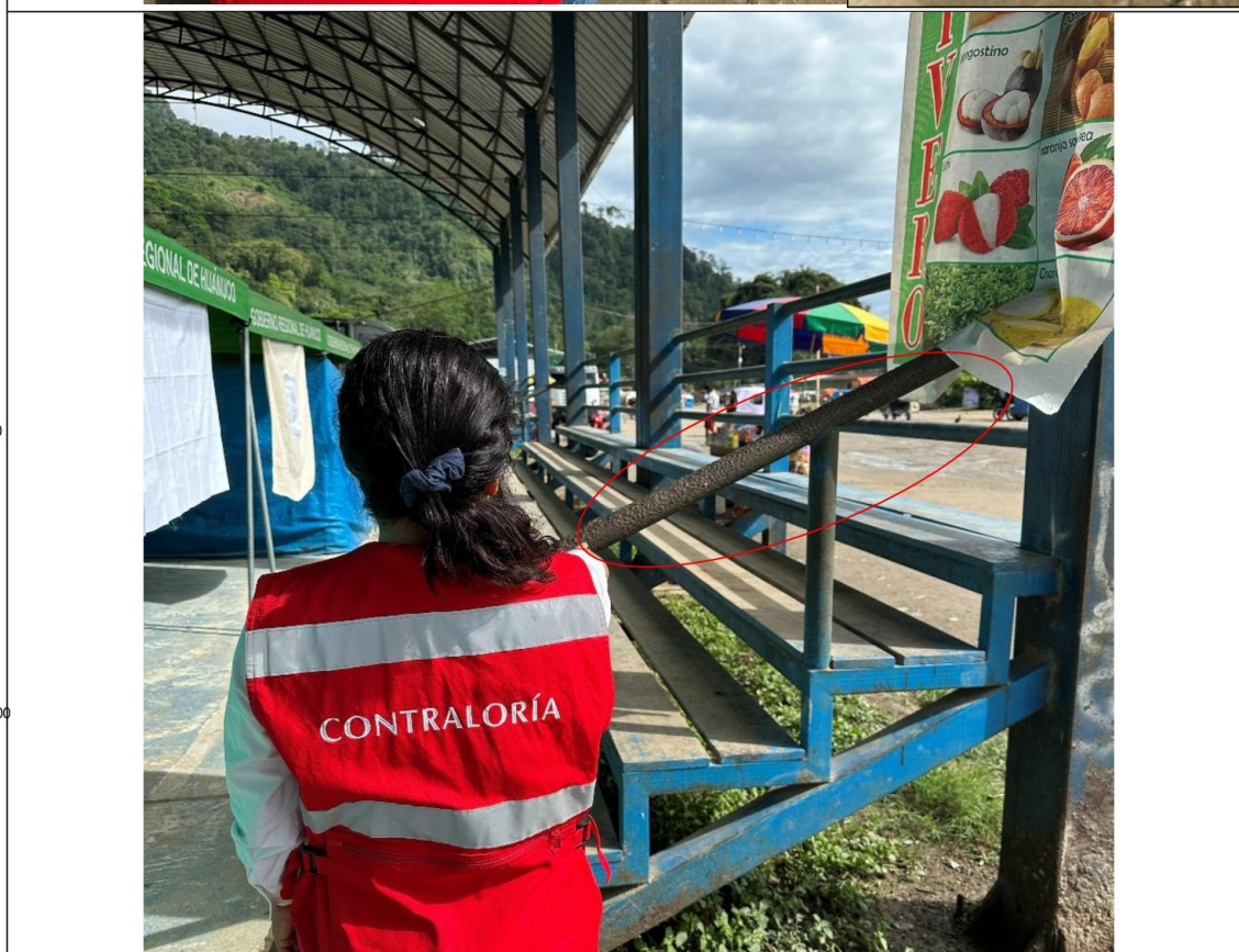
Tribuna de estructura metálica y baranda metálica en estado de corrosión debajo de la cobertura 1
