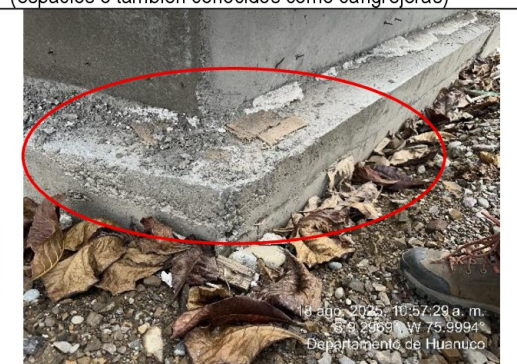
Segregación del agregado de mezcla de concreto (espacios o también conocidos como cangrejeras)
