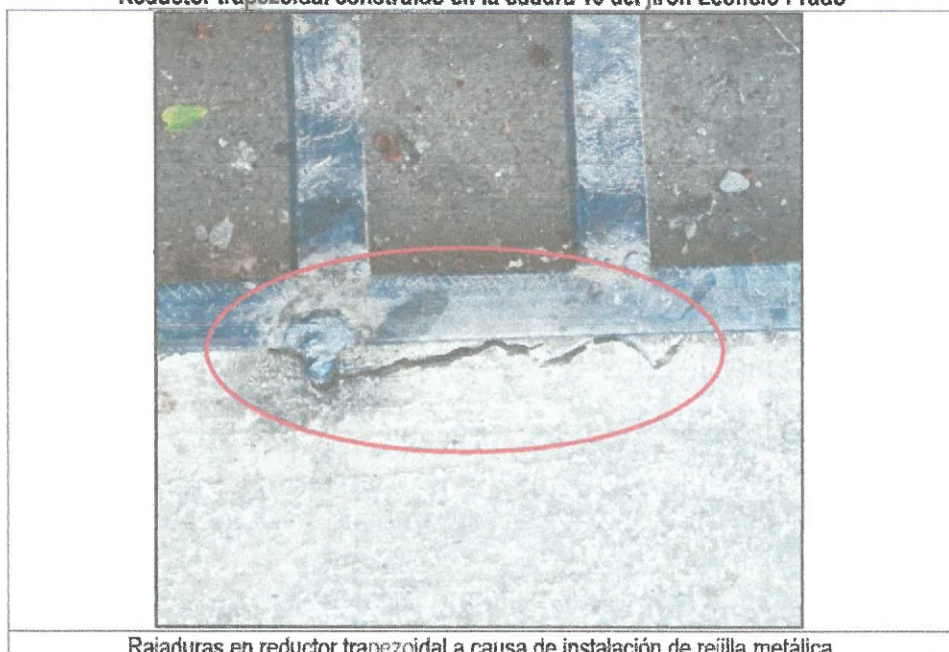
Rajaduras en reductor trapezoidal a causa de instalación de rejilla metálica.
