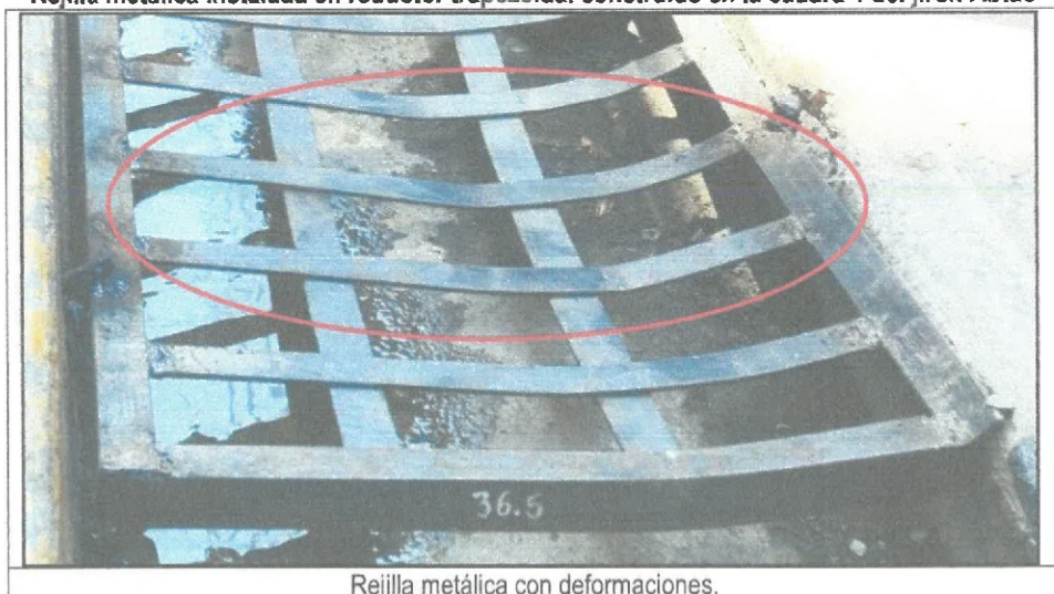
Rejilla metálica con deformaciones.
