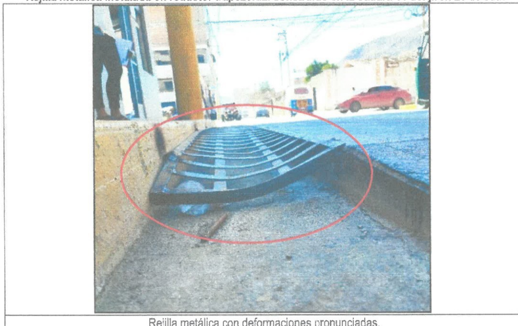
Rejilla metálica con deformaciones pronunciadas.
