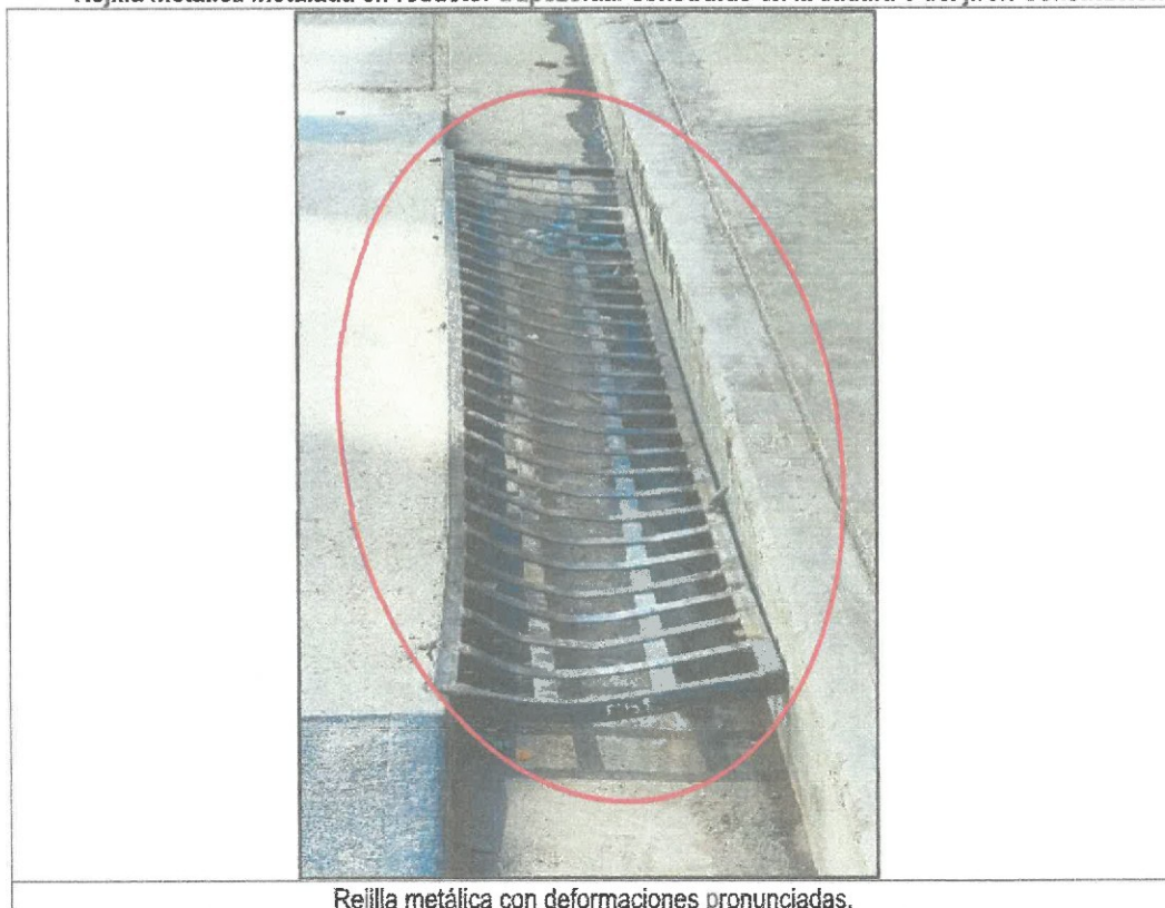
Rejilla metálica con deformaciones pronunciadas.
