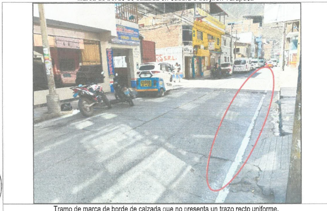
Tramo de marca de borde de calzada que no presenta un trazo recto uniforme.
