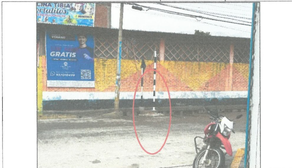
Vista Fotográfica n.º 12 Instalación de tubo metálico (señalización vertical)
