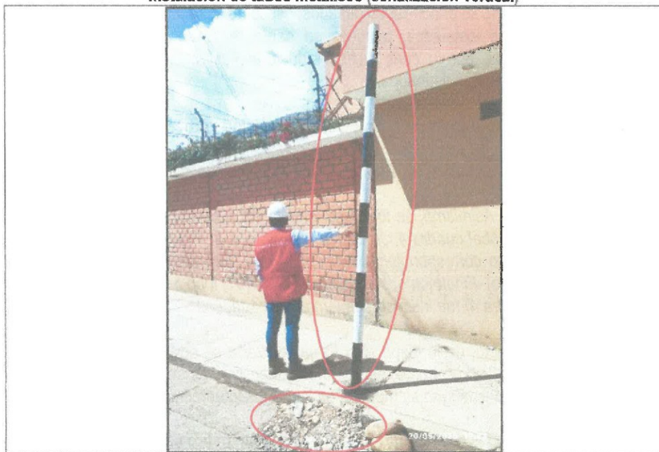
Vista Fotográfica n.º 5 Instalación de tubos metálicos (señalización vertical)
