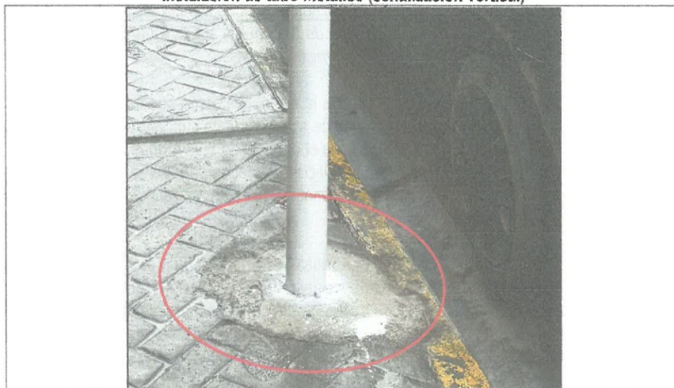
Vista Fotográfica n.º 17 Instalación de tubo metálico (señalización vertical)
