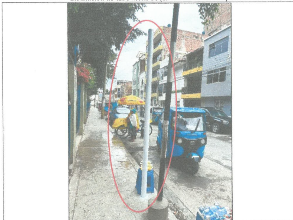
Vista Fotográfica n.º 13 Instalación de tubo metálico (señalización vertical)
