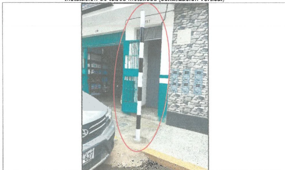
Vista Fotográfica n.º 6 Instalación de tubos metálicos (señalización vertical)
