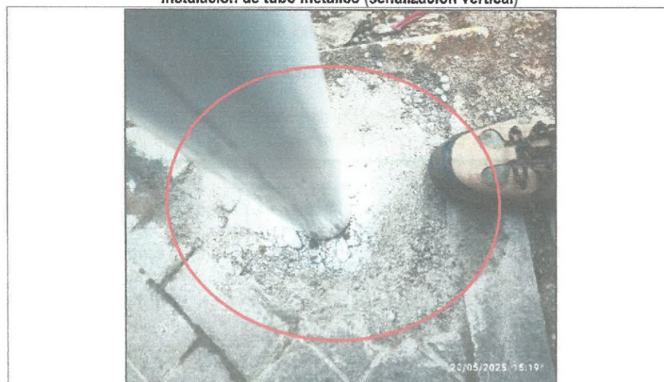
Vista Fotográfica n.º 18 Instalación de tubo metálico (señalización vertical)
