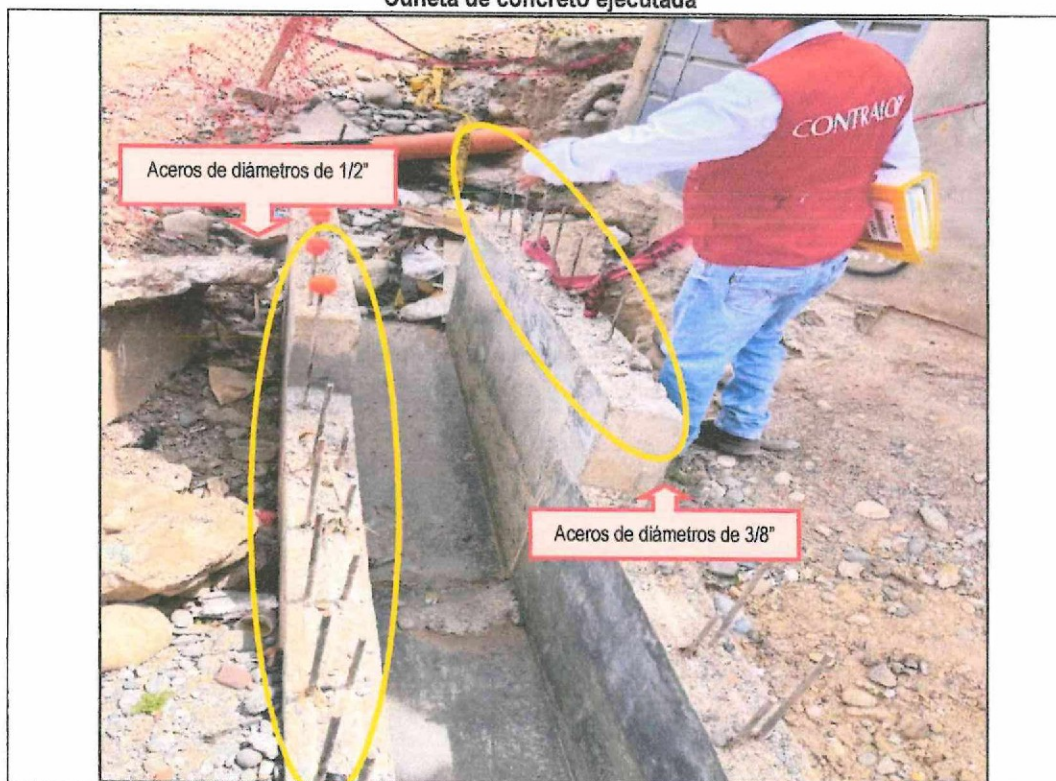
Vista fotográfica n.º 14 Cuneta de concreto ejecutada
