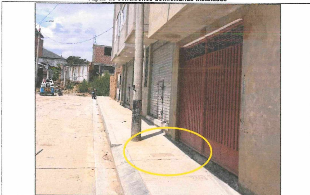
Vista fotográfica n.º 9 Tapas de conexiones domiciliarias instaladas
