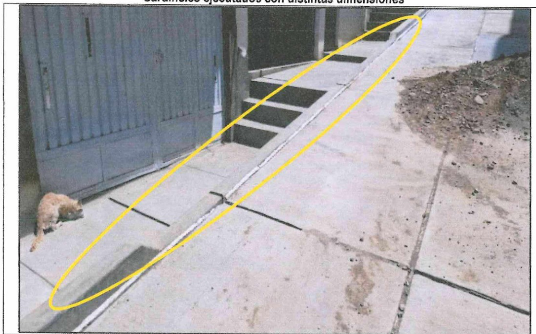
Vista fotográfica n.º 4 Sardineles ejecutados con distintas dimensiones
