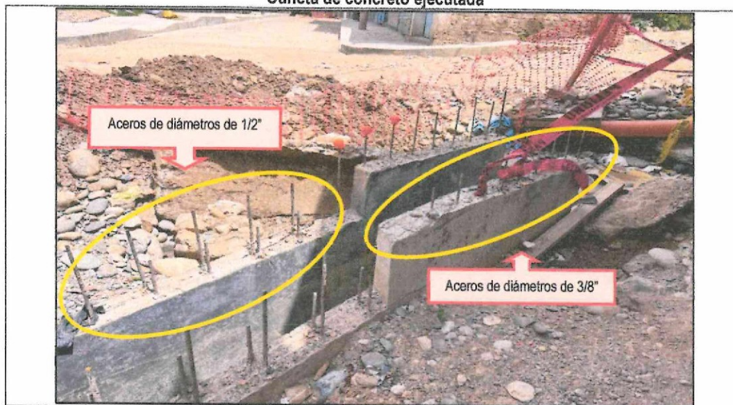
Vista fotográfica n.º 13 Cuneta de concreto ejecutada
