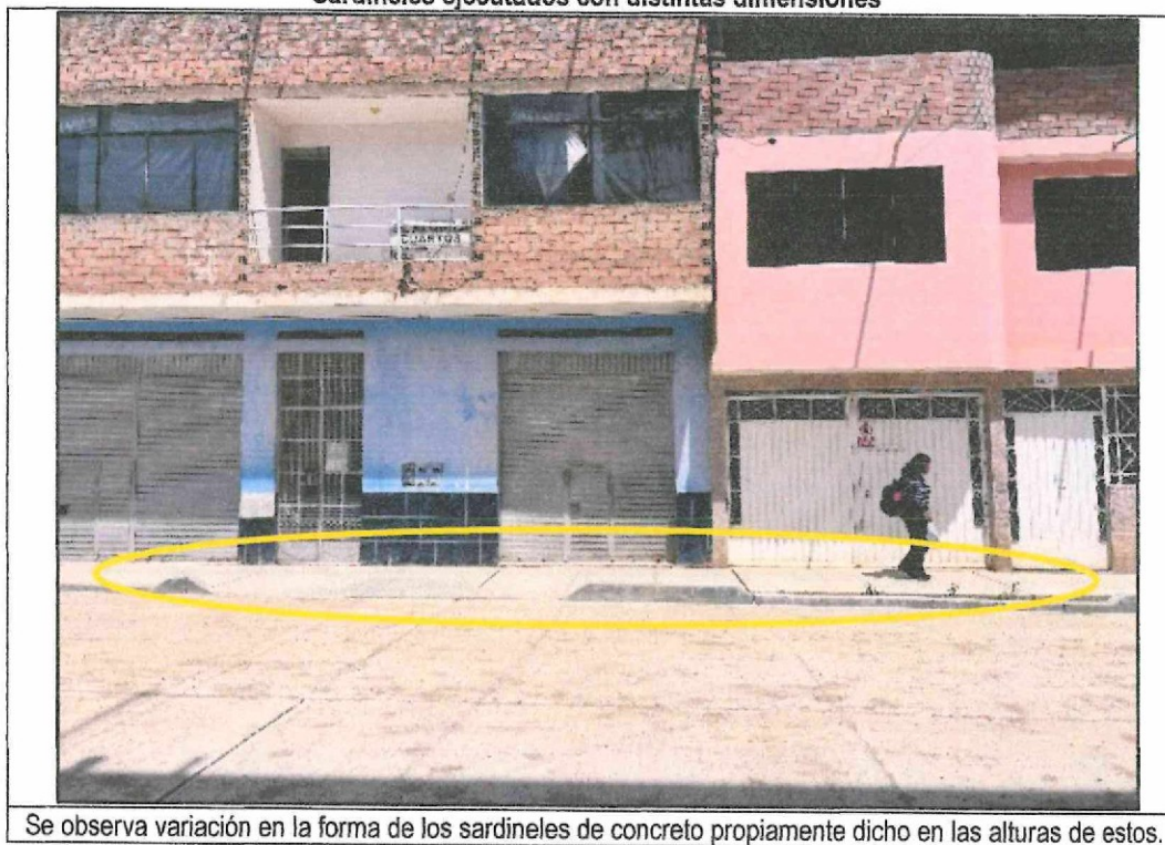
Vista fotográfica n.º 2 Sardineles ejecutados con distintas dimensiones
