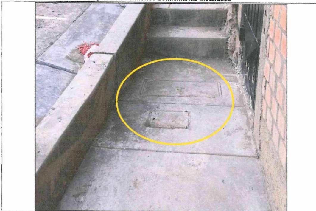
Vista fotográfica n.º 8 Tapas de conexiones domiciliarias instaladas
