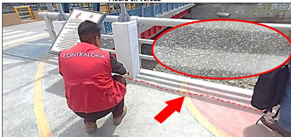
Imagen n.º 7: Fisura longitudinal ubicada en la vereda aguas abajo del Malecón Santa Rosa.
