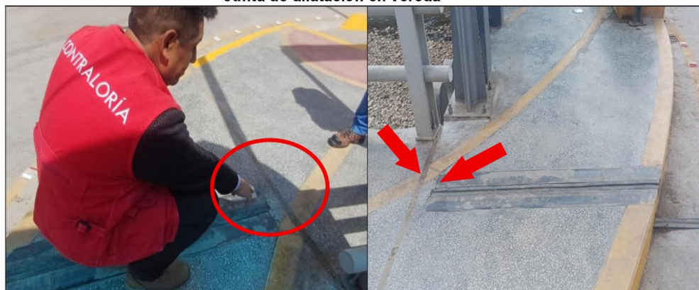
Imágenes n.ºs 10 y 11: Junta de dilatación en vereda no culmina en junta de construcción del muro de contención.
