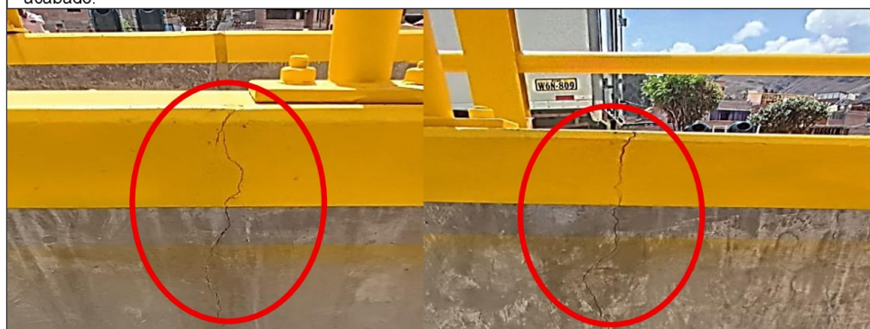
Imágenes n.ºs 5 y 6: Acabado en muros para la rampa de acceso ubicados en el Malecón Santa Rosa (margen derecho), presentan fisuras.
