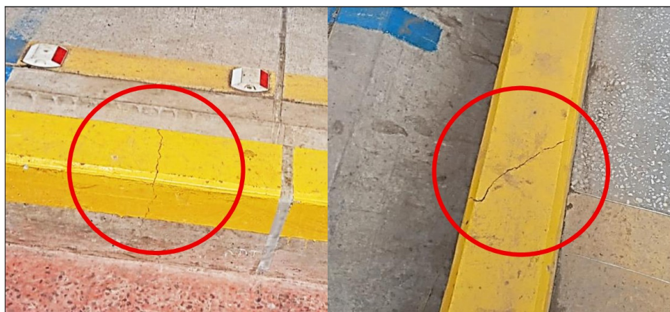
Imágenes n.ºs 3 y 4: Sardineles de la vía de acceso al puente (margen derecho), presentan fisuras en su acabado.
