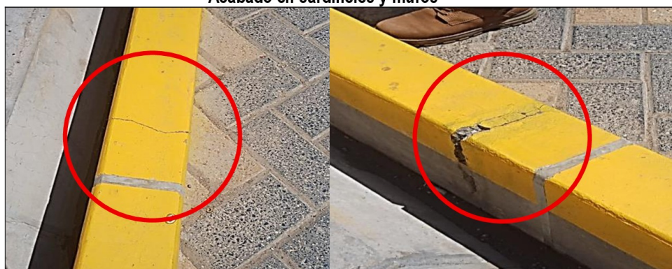
Imágenes n.°s 1 y 2: Sardineles de la vía de acceso al puente del Malecón Virgen de la Candelaria (margen izquierdo), presentan fisuras en su acabado.
