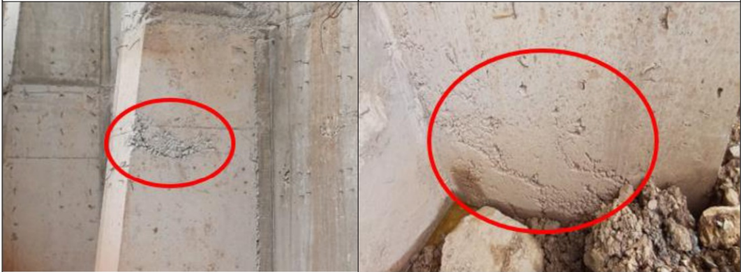
Imágenes n.ºs 47 y 48: Presencia de cangrejas tanto en base y cuerpo de contrafuerte.
