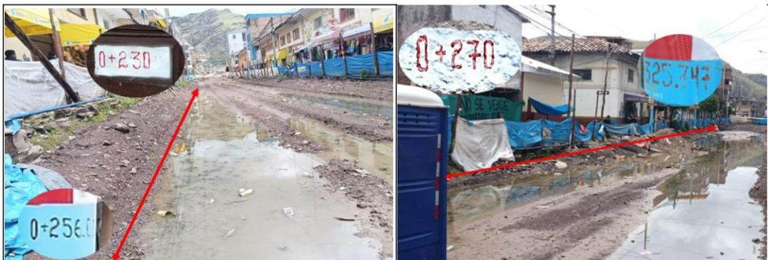
**Imagen n.º 8:** El tramo 1 comprendido del Jr. Sebastián Barranca al Jr. José María Chávez, desde la progresiva 0+230 hasta 0+256, con acumulación de agua producto de las precipitaciones pluviales.
