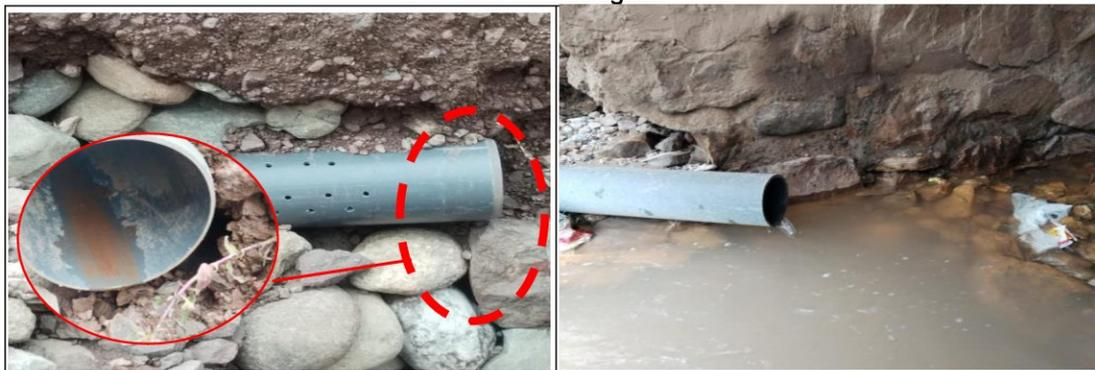
**Imagen n.º 13:** Se muestra el final de la tubería del sub dren proveniente del Psje. Grau hacia la alcantarilla (progresiva 0+345), sin escurrimiento de agua.
