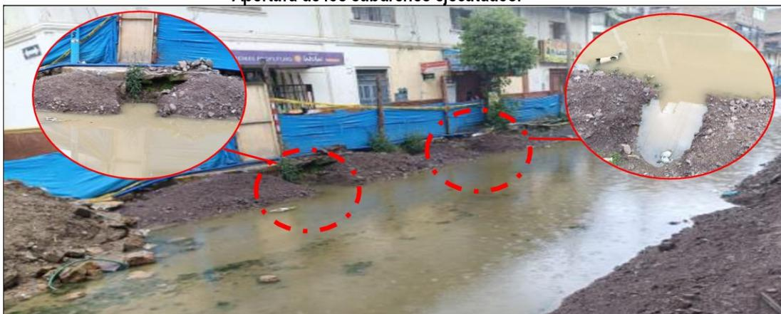
**Imagen n.º 10:** Se muestra la apertura en la margen izquierda hacia el sub dren existente para drenar el agua acumulada, sin embargo, las aperturas se encuentran colmatadas.
