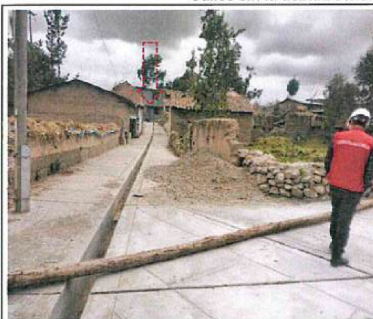
Descripción: Calle Sin Nombre N° 6 C1, sin señalización ni cerramiento adecuado que restrinja el paso de transeúntes.
