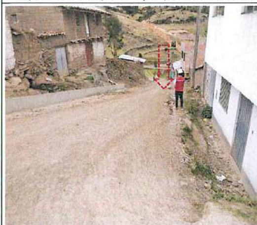
Descripción: Calle Augusto B. Leguía C1, sin señalización ni tranquera adecuado que restrinja el paso de transeúntes.
