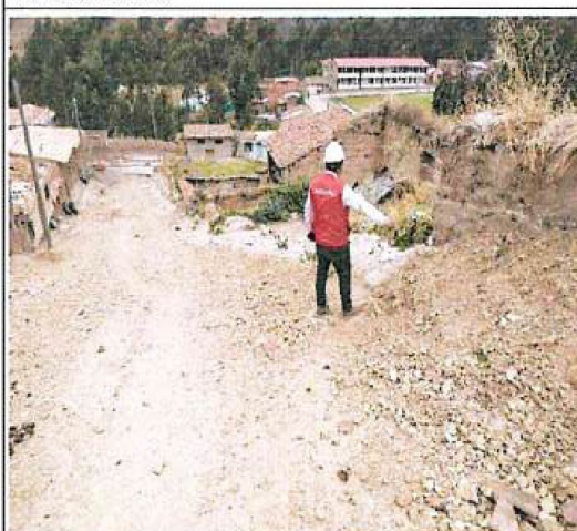
Descripción: Calle Hipólito Unanue C1, sin señalización.
