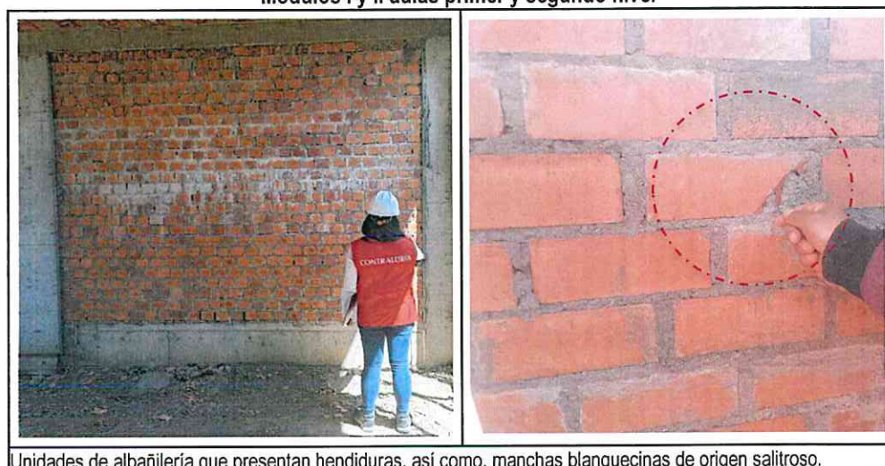
Panel fotográfico n.º 3 Módulos I y II aulas primer y segundo nivel
