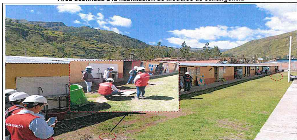
Panel fotográfico n.º 6 Área destinada a la habilitación de módulos de contingencia
