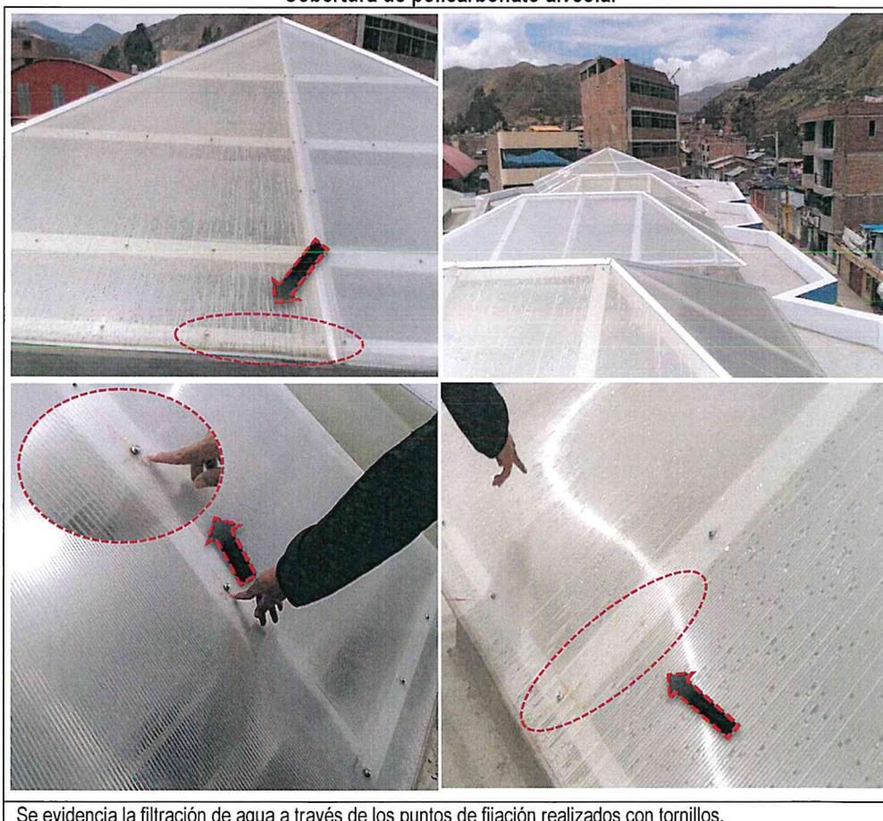
Se evidencia la filtración de agua a través de los puntos de fijación realizados con tornillos.
