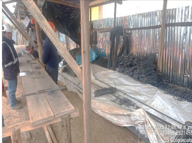
Imagen n.º 3 Habilitación de acero para placas, columnas, vigas de cimentación y vigas de conexión.
