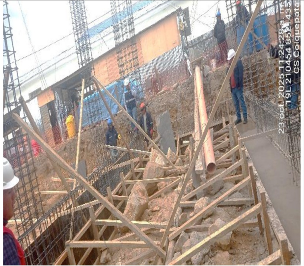
Imagen n.º 2 Trabajos de encofrado de la base de la viga de cimentación eje B del Bloque A1
