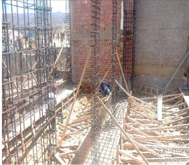
Imagen n.º 1 trabajos de armado de acero en la base de la viga de cimentación eje B del Bloque A1
