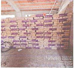
Se observa que el cemento se encuentra almacenado en contacto con el suelo, sin protección
