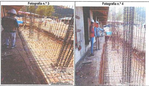
Durante la inspección se identificó una excavación con presencia de varillas de refuerzo expuestas. El área no cuenta con señalización, cintas de seguridad ni barandas de protección.
